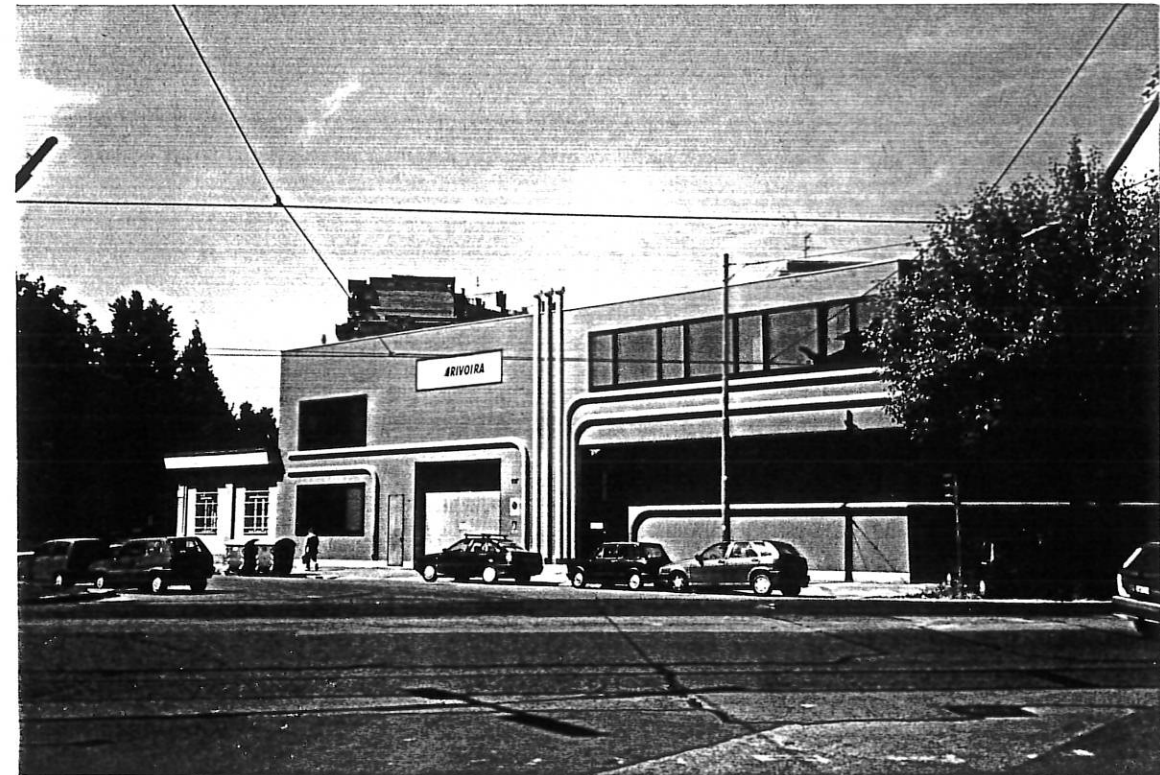
④ VISTA DALLO SLARGO VIARIO TRA CORSO BELGIO E CORSO BRIANZA
