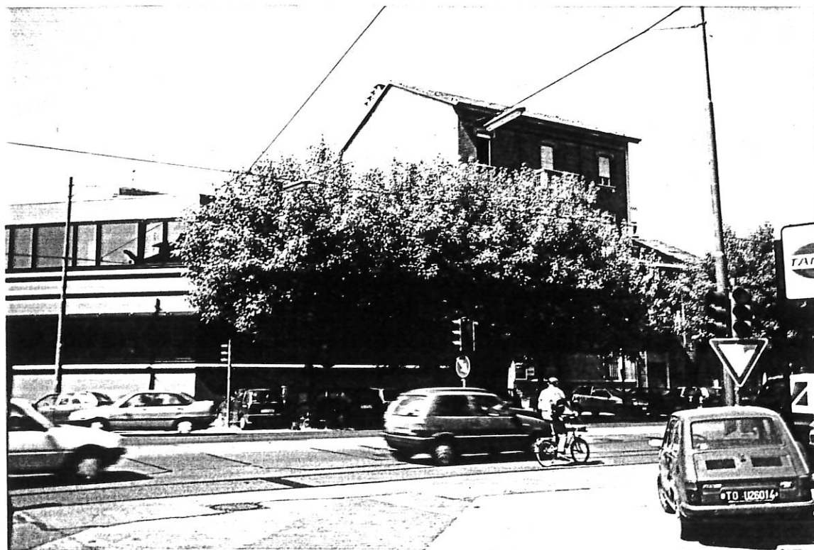
⑤ VISTA VERSO CORSO BELGIO
