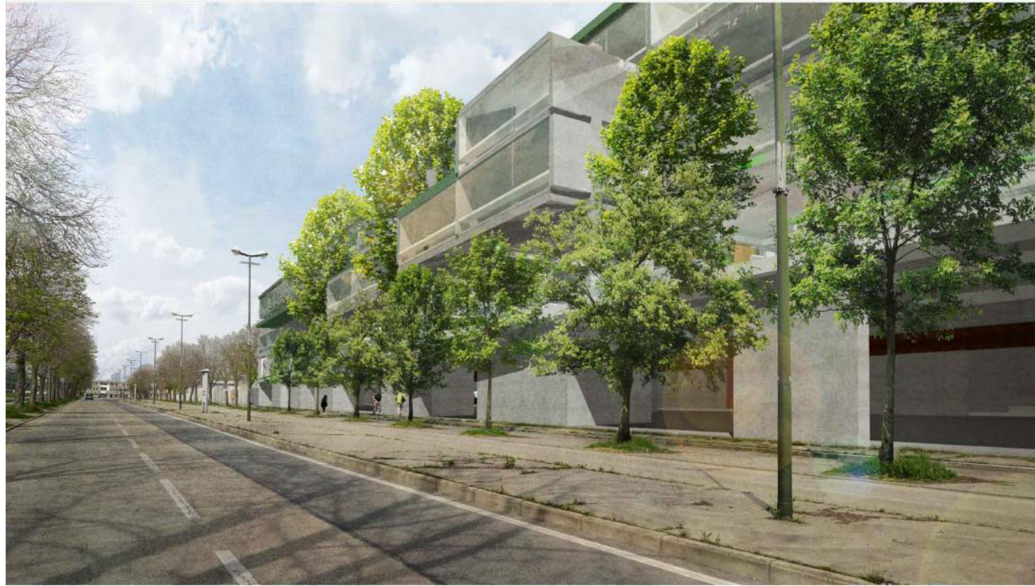
ESTERNO SU VIA TRAVES
