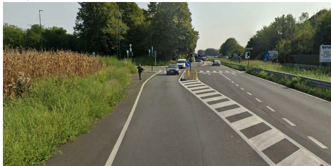
Figura 14 - Intersezione semaforizzata corso Romania e sovrappasso Falchera
