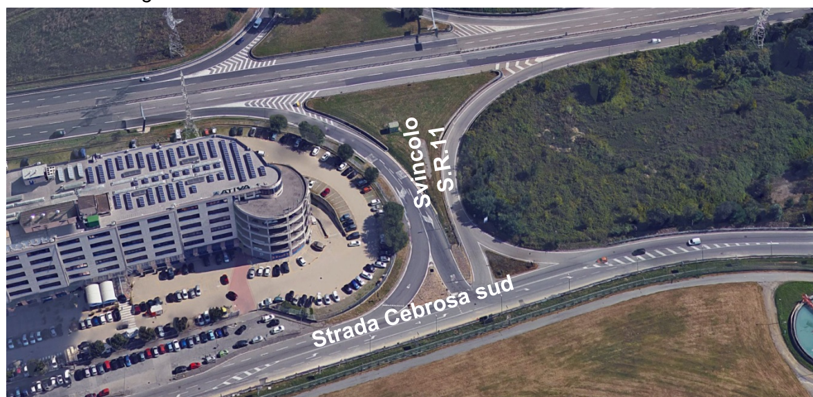
Figura 17 - Svincolo "Abbadia di Stura" - A55 raccordo Falchera
