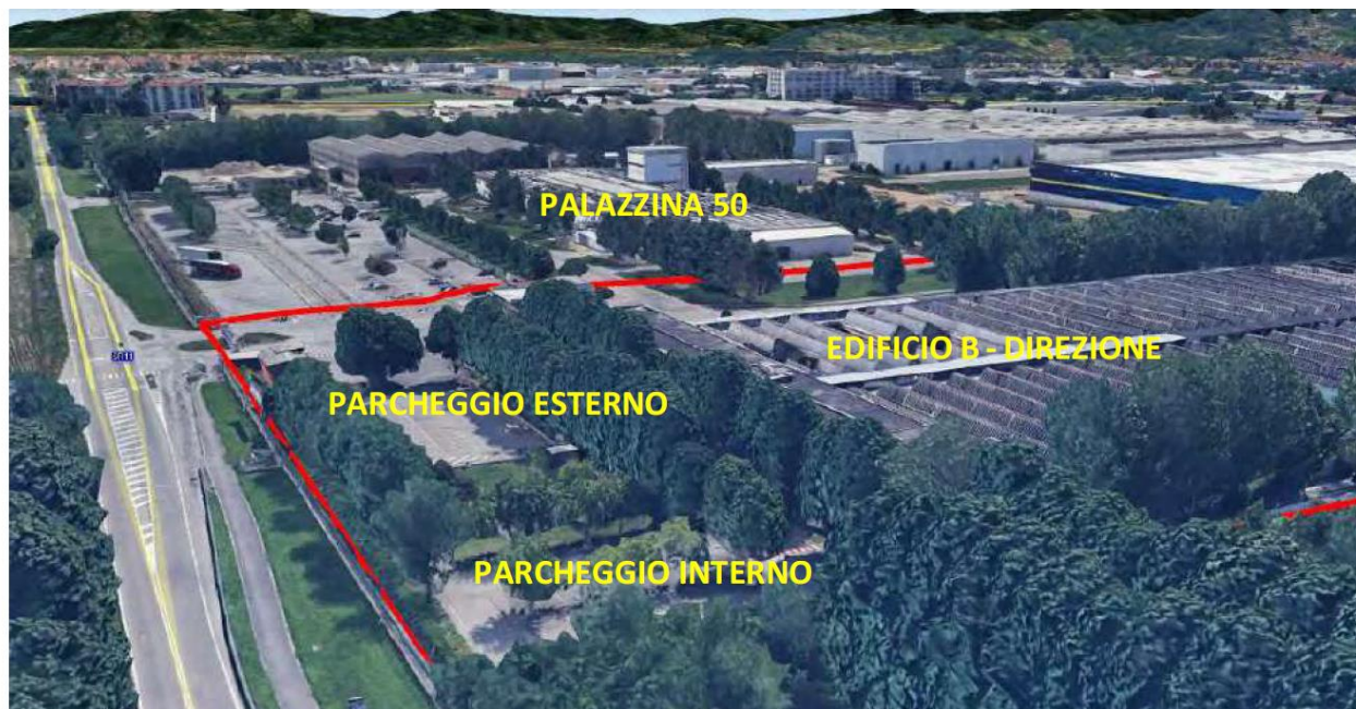
Figura 45: Area antistante l'edificio Direzione
