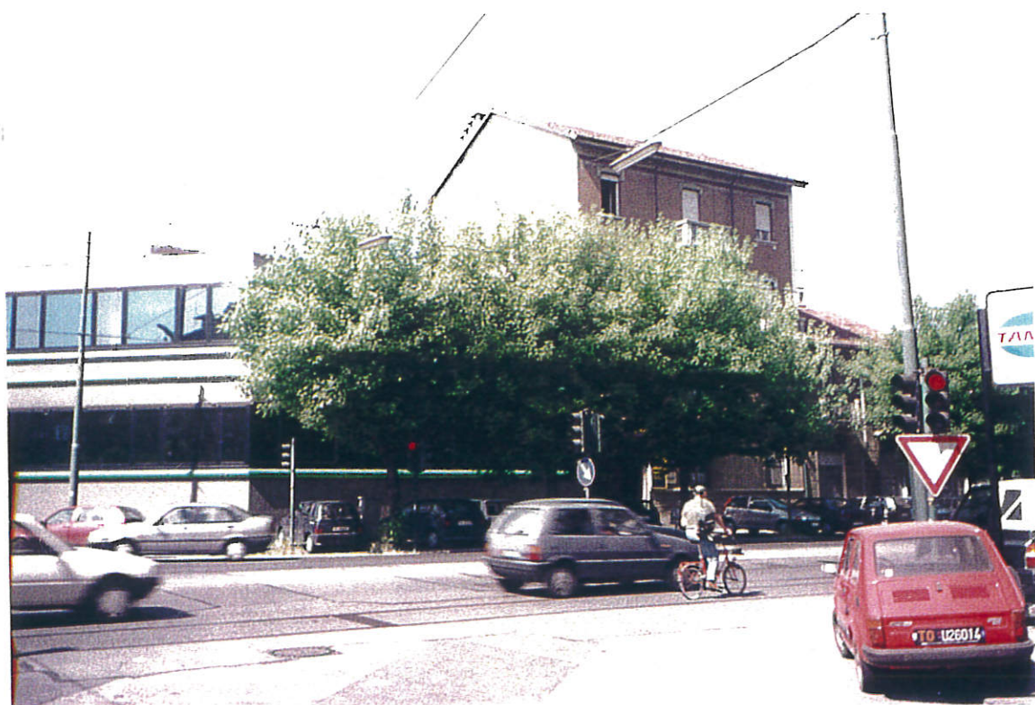
⑤ VISTA VERSO CORSO BELGIO
