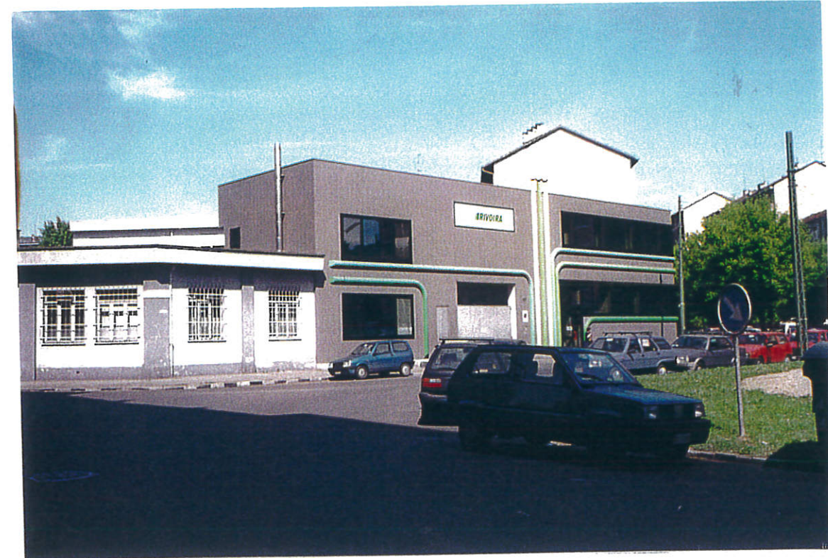
① VISTA DALLO SLARGO VIARIO TRA CORSO BELGIO E CORSO BRIANZA
