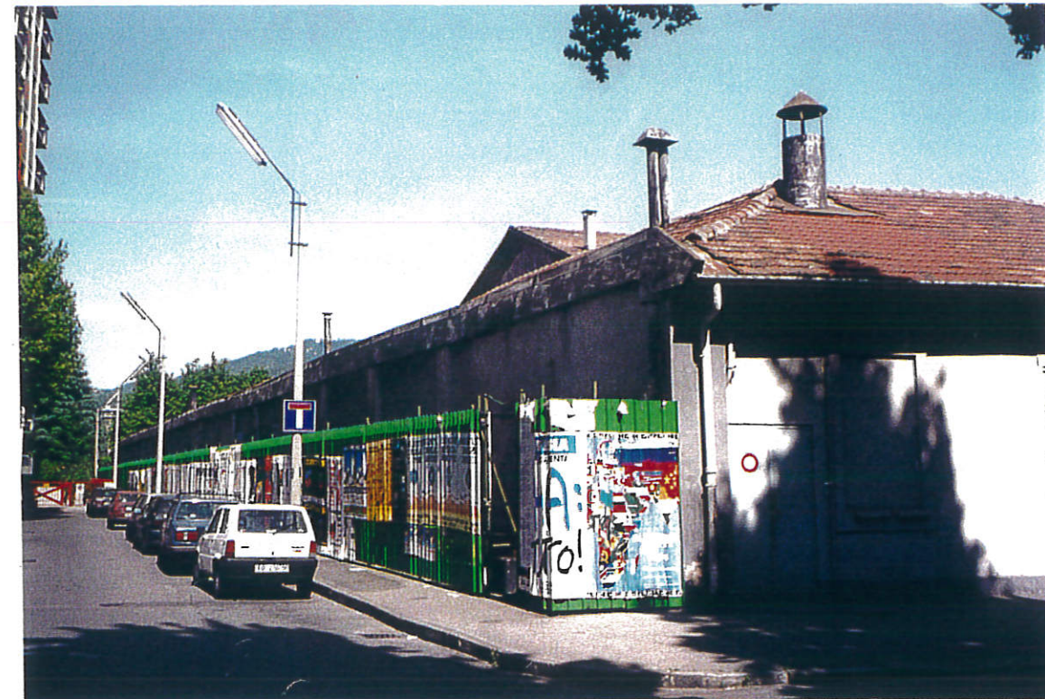
③ VISTA VERSO LA VIA PRIVATA
