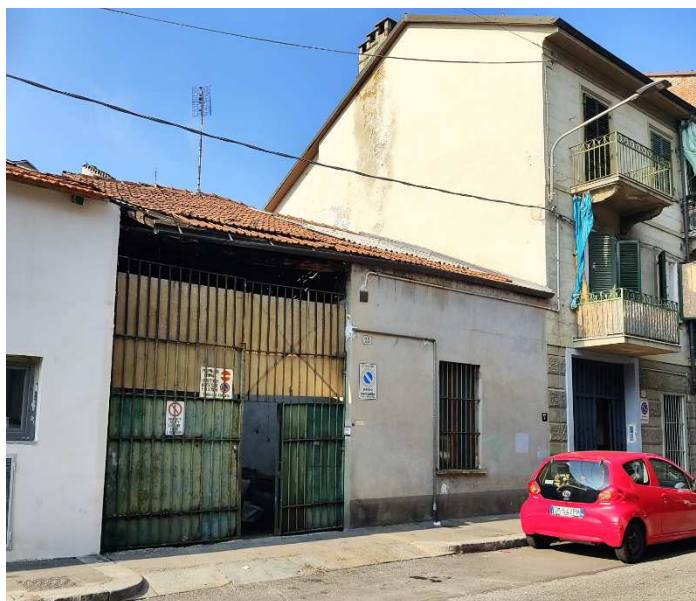
L'edificio ad un piano f.t. di via Monte Rosa n. 23
