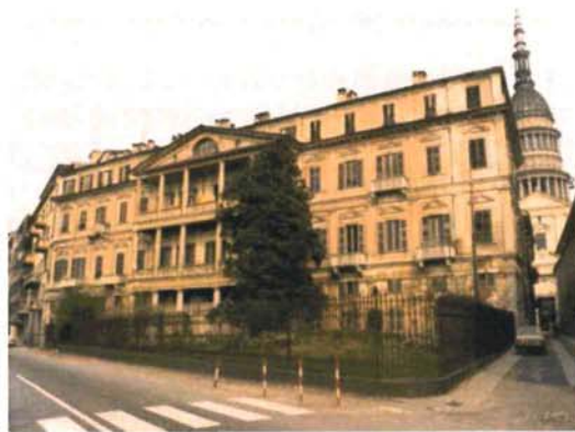
Figura 3 – Prospetto principale sul Baluardo
