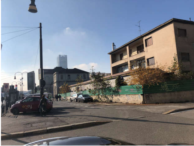
Sito della futura attività
