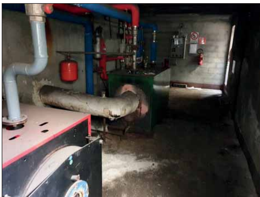
- Locale al piano interrato con potenziale presenza di cisterna interrata -
