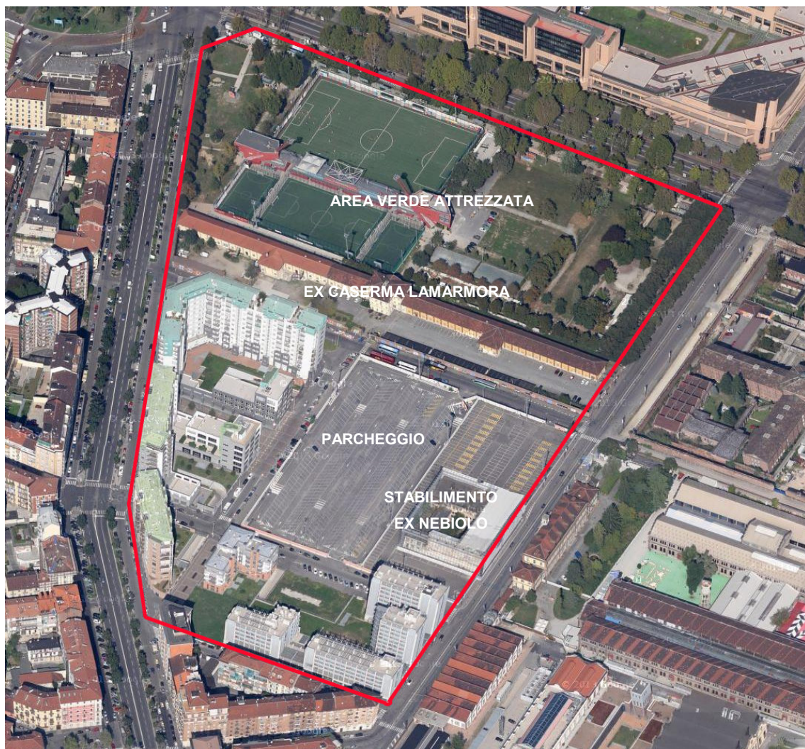
Figura 2: Vista aerea dell'area.
