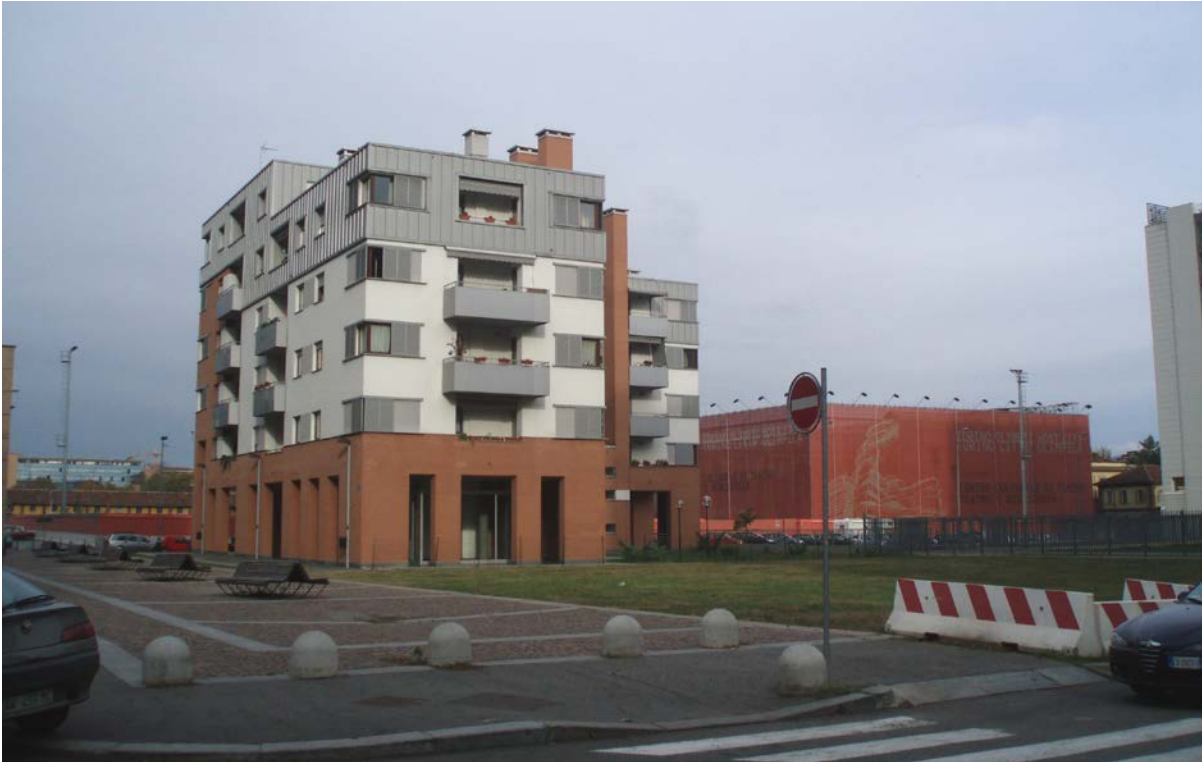
Figura 52 - UI2 - Edilizia convenzionata
