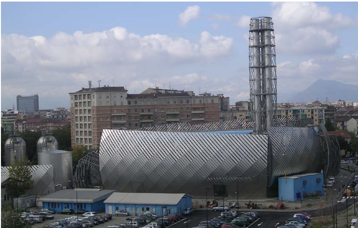
Figura 30 - Centrale termica, corso Ferrucci. Una delle moderne infrastrutture di servizio localizzate sul corso.
