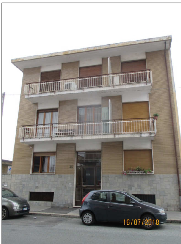
Via Bard n. 36: stato di fatto dei luoghi: fabbricato residenziale
