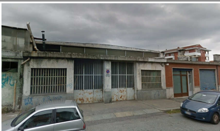
Via Bard n. 5c: stato di fatto dei luoghi: magazzino
