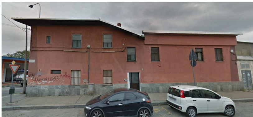
Via Bard n. 1d: stato di fatto dei luoghi: residenza
