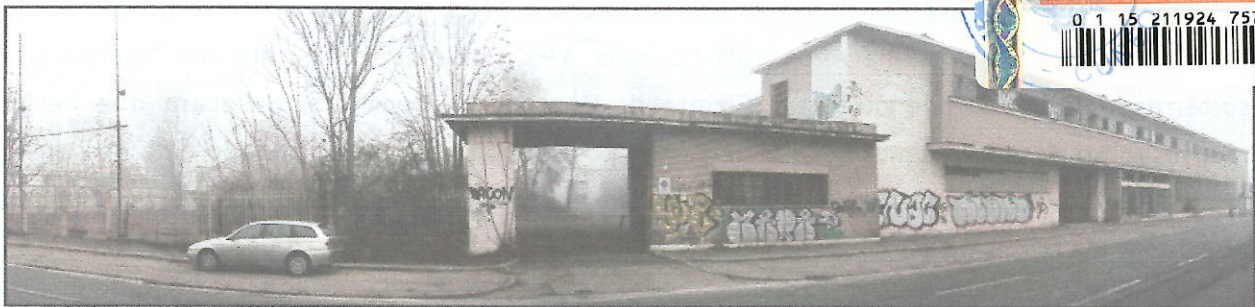
Vista panoramica dell'ingresso su via Botticelli
