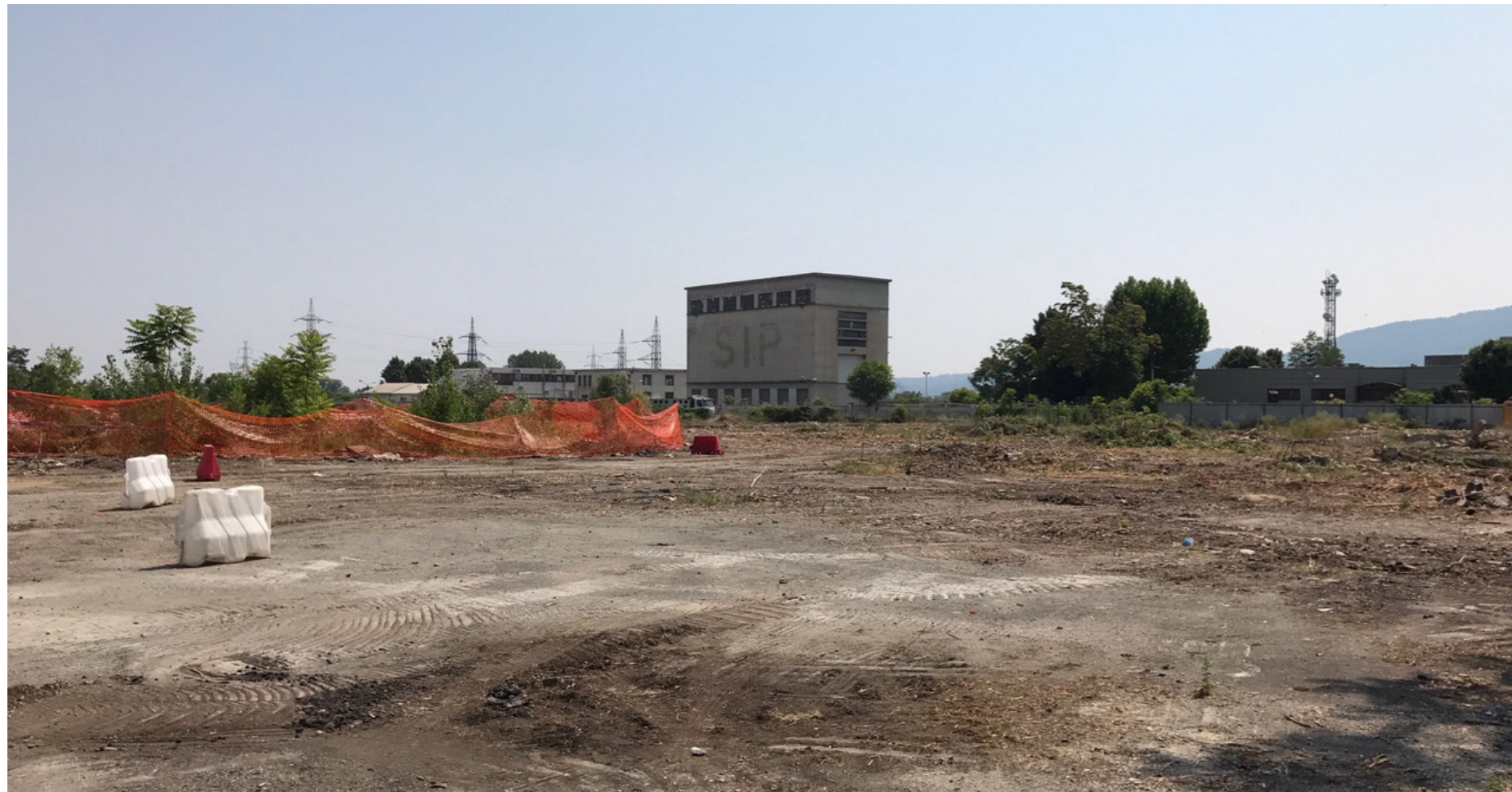
FOTO 1 - VISTA DEL CANTIERE DIREZIONE EST
