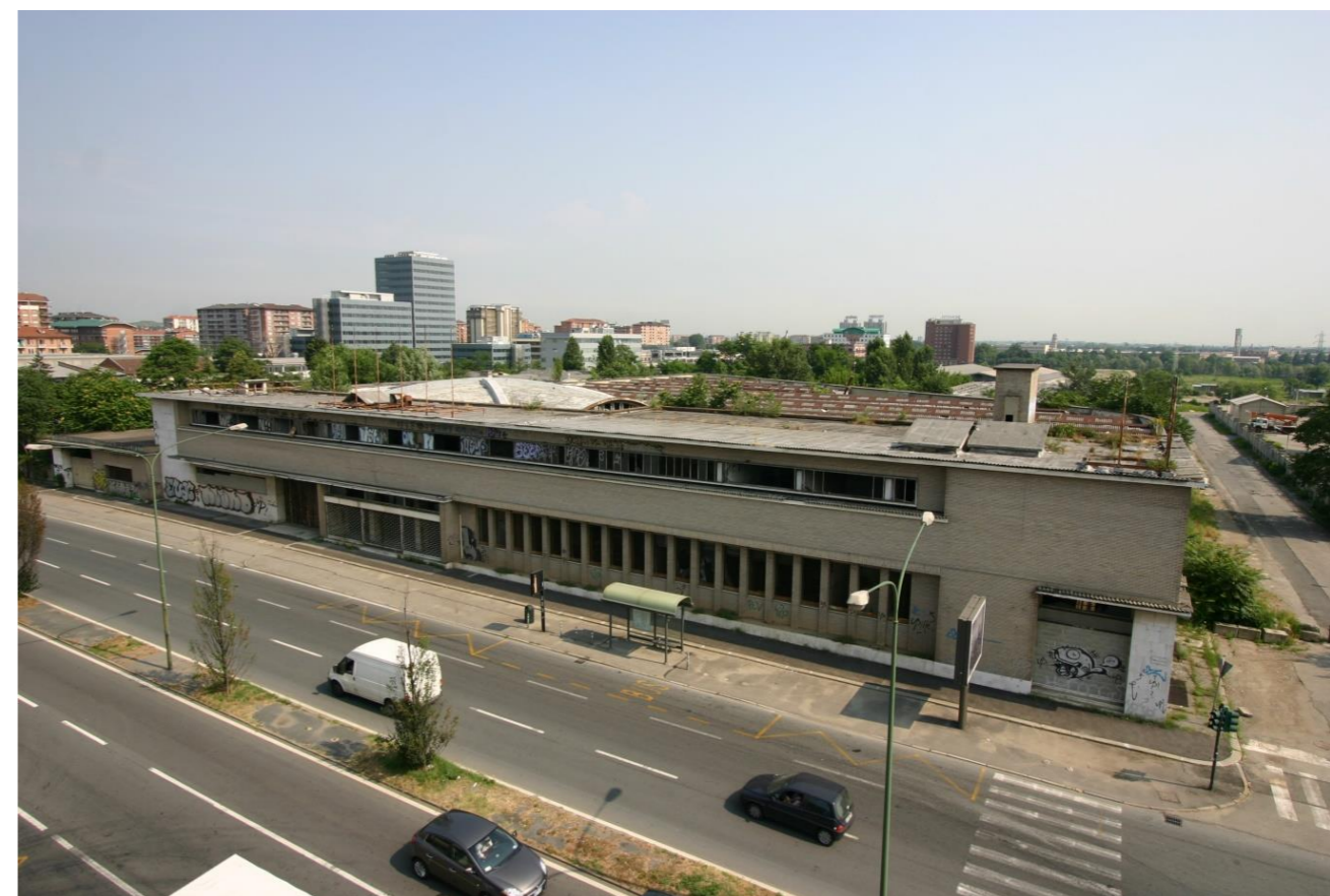
Figura 2 – Il complesso immobiliare prima della demolizione
