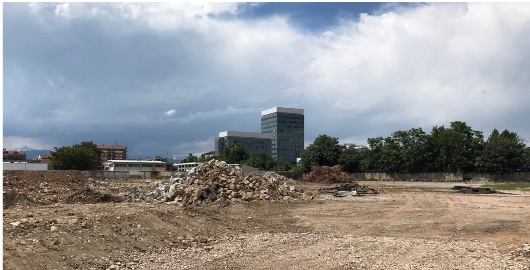
FOTO 2 - VISTA DEL CANTIERE DIREZIONE NORD
