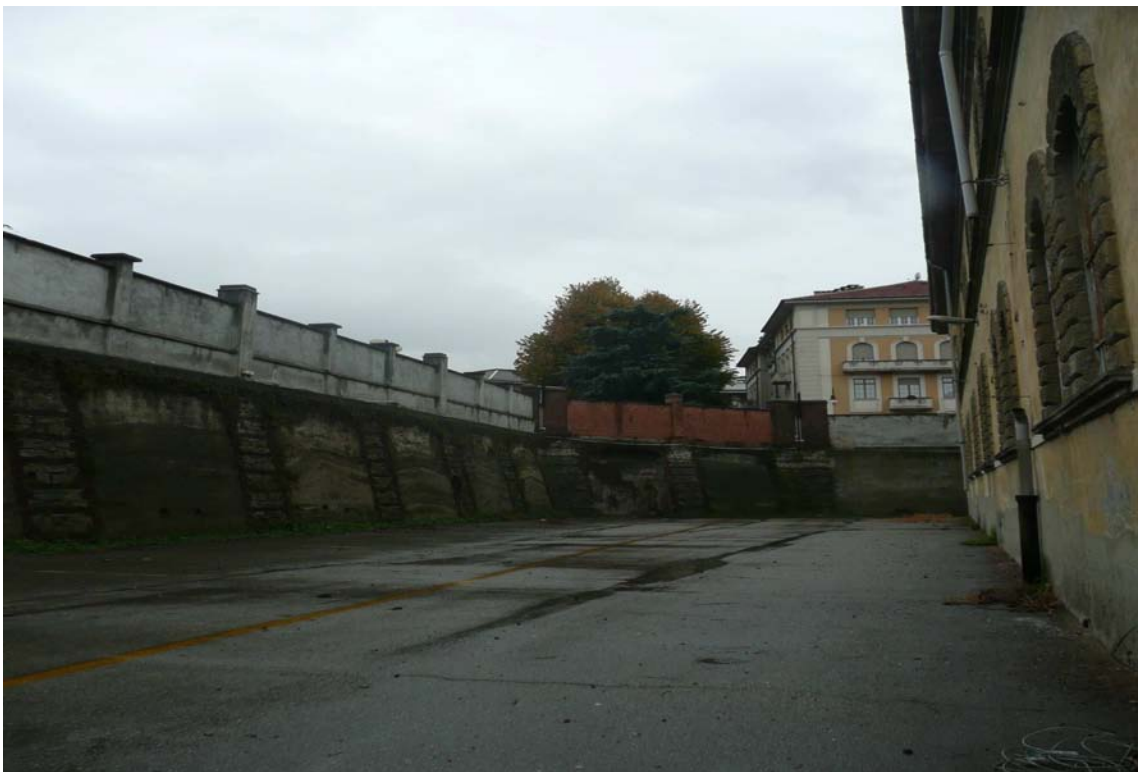
vista lato corso Quintino Sella angolo via Cardinale Maurizio interno cortile
