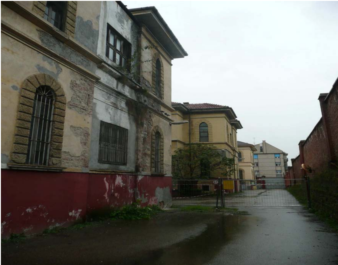
vista lato via Bricca interno cortile
