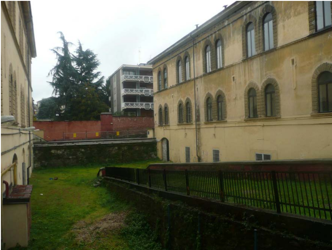
vista lato via Bricca interno cortile
