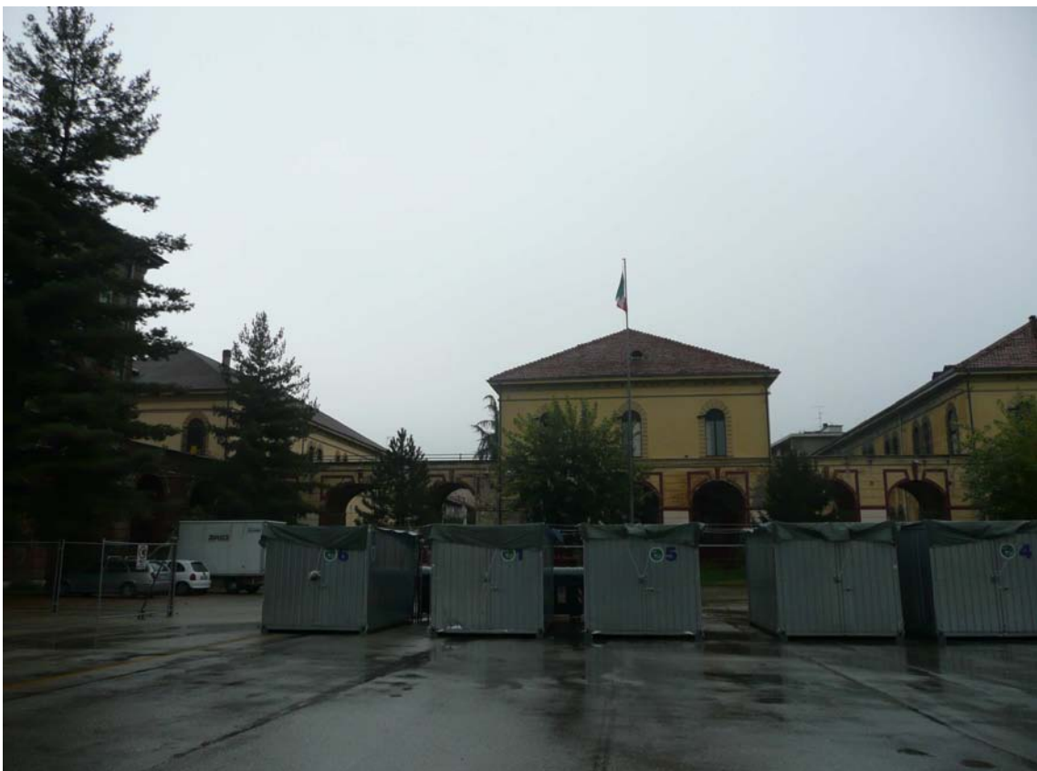
vista lato via Bricca interno cortile
