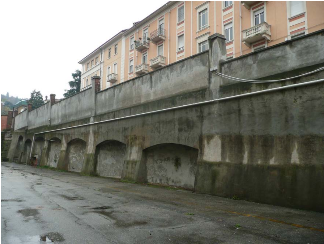
vista lato via Cardinale Maurizio interno cortile
