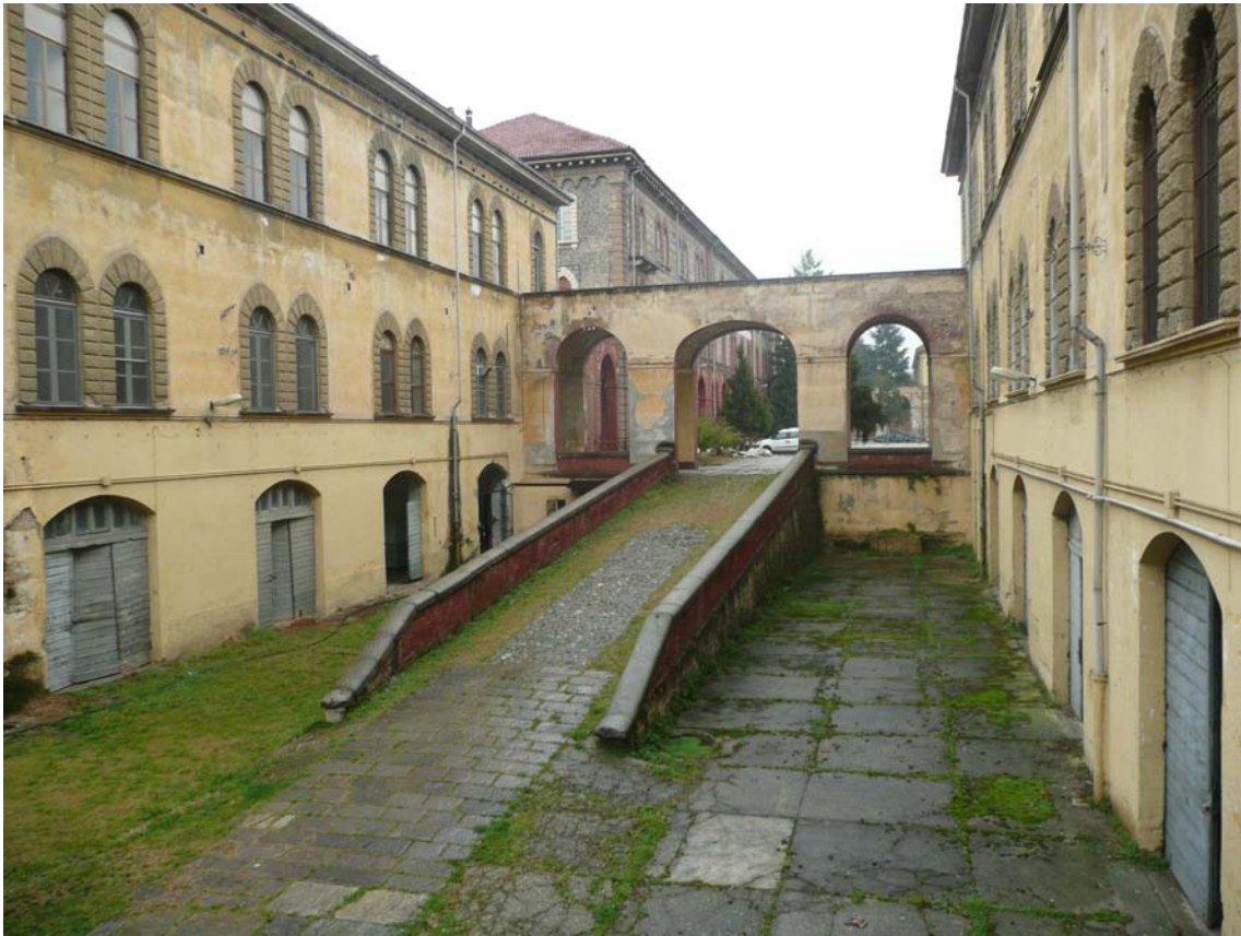
vista lato via Cardinale Maurizio angolo via Asti interno cortile
