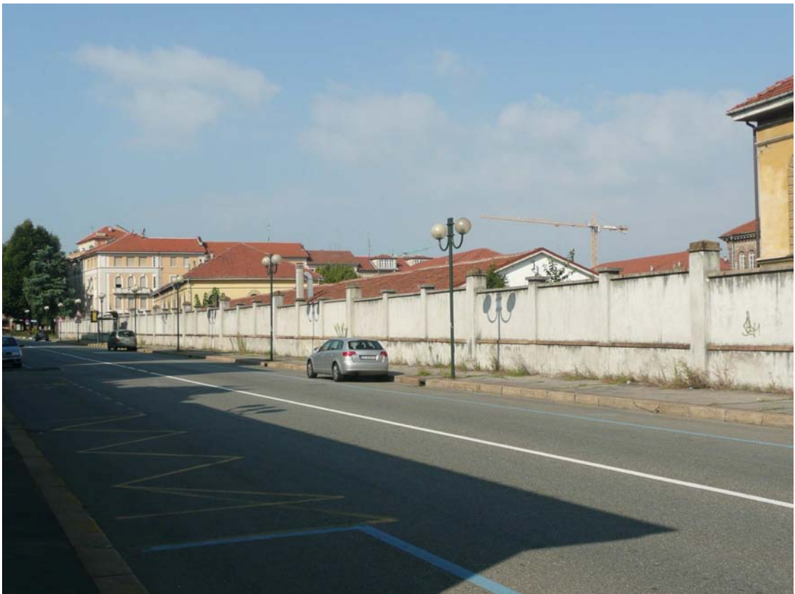
vista lato corso Quintino Sella
