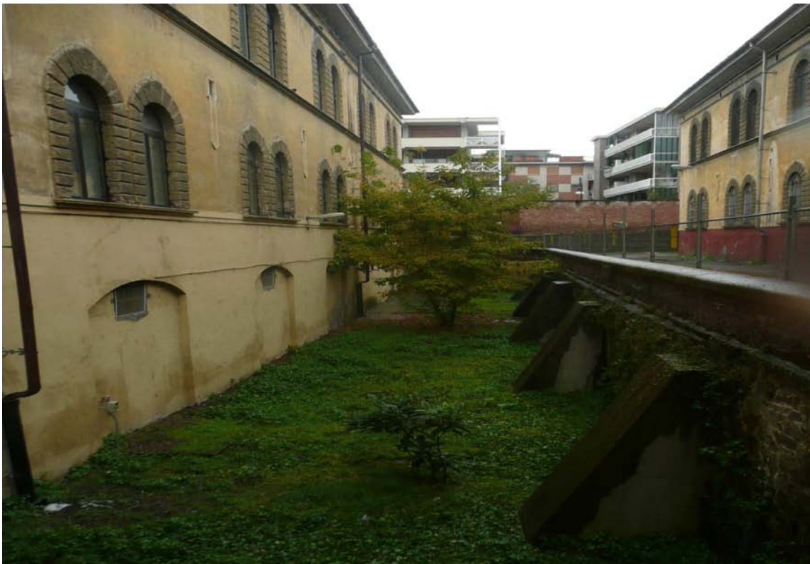
vista lato via Bricca interno cortile
