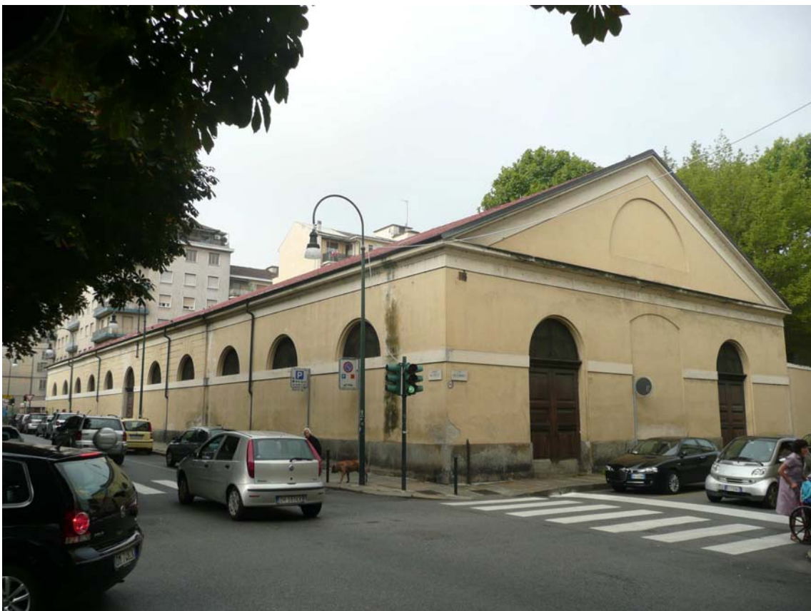
vista laterale corso Valdocco angolo via San Domenico
