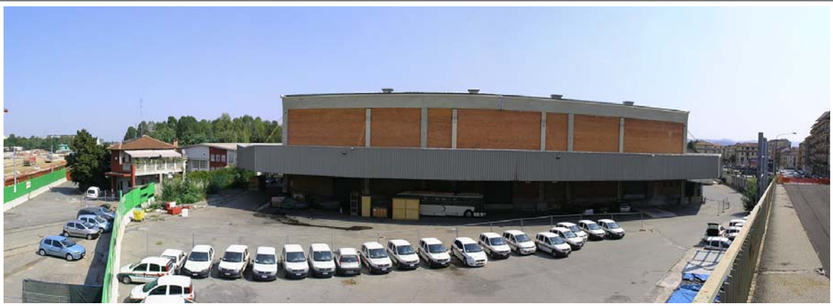
Metallurgica piemontese allo stato attuale (da via Rossi)
