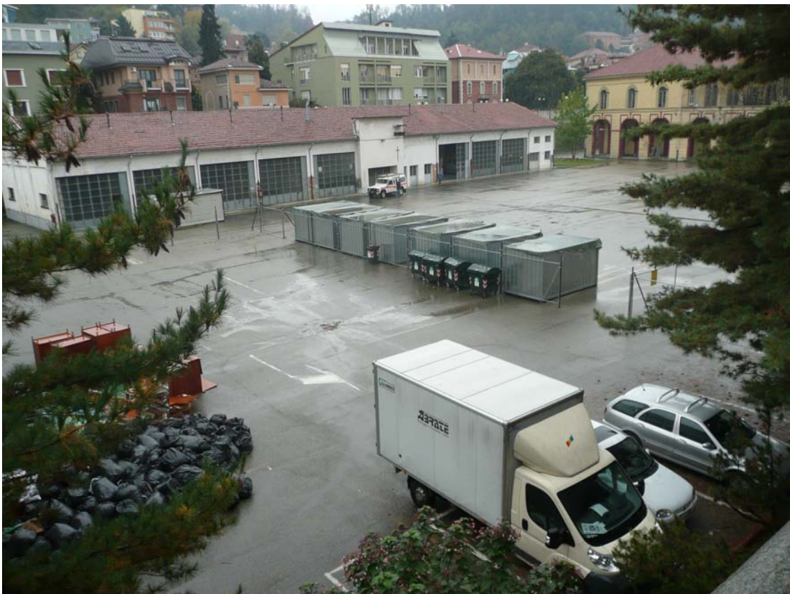
vista lato corso Quintino Sella angolo via Cardinale Maurizio interno cortile
