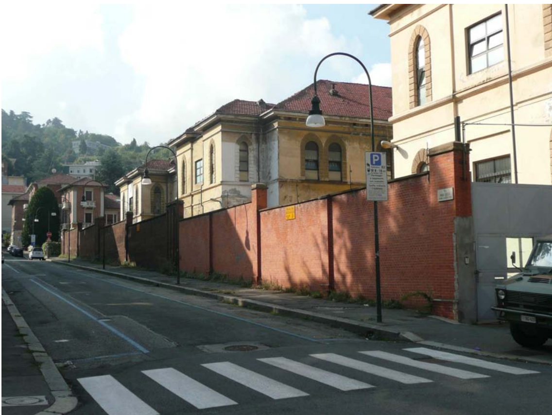
vista lato via Bricca angolo via Asti
