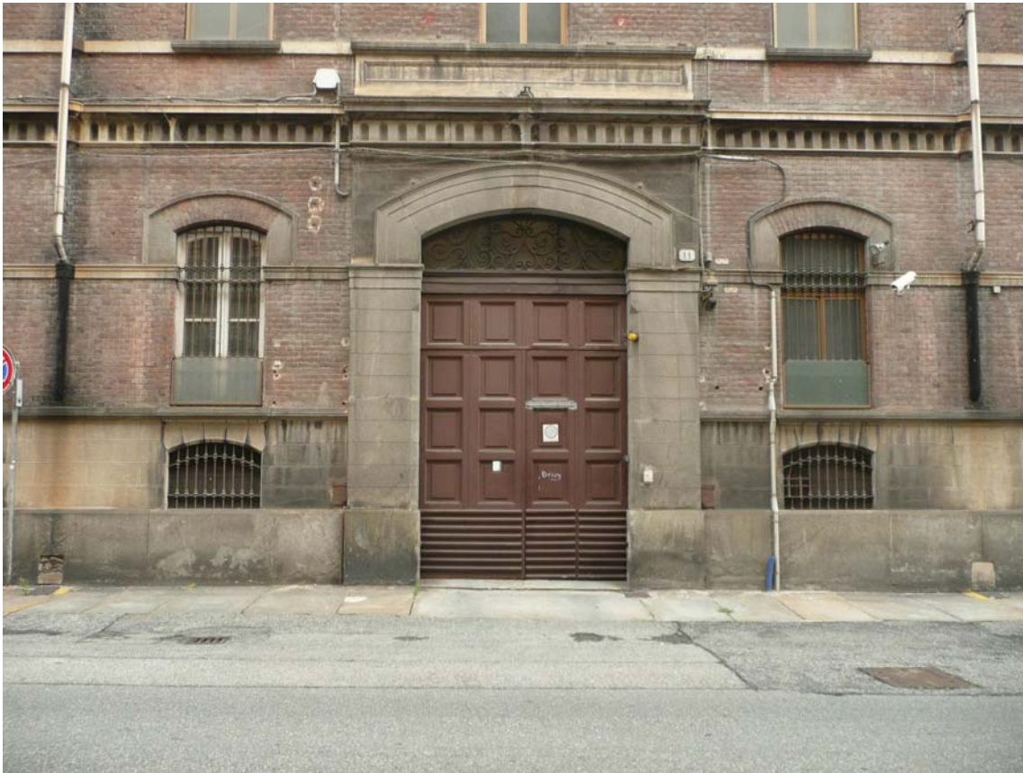
vista laterale ingresso carroia in via Revel n. 11
