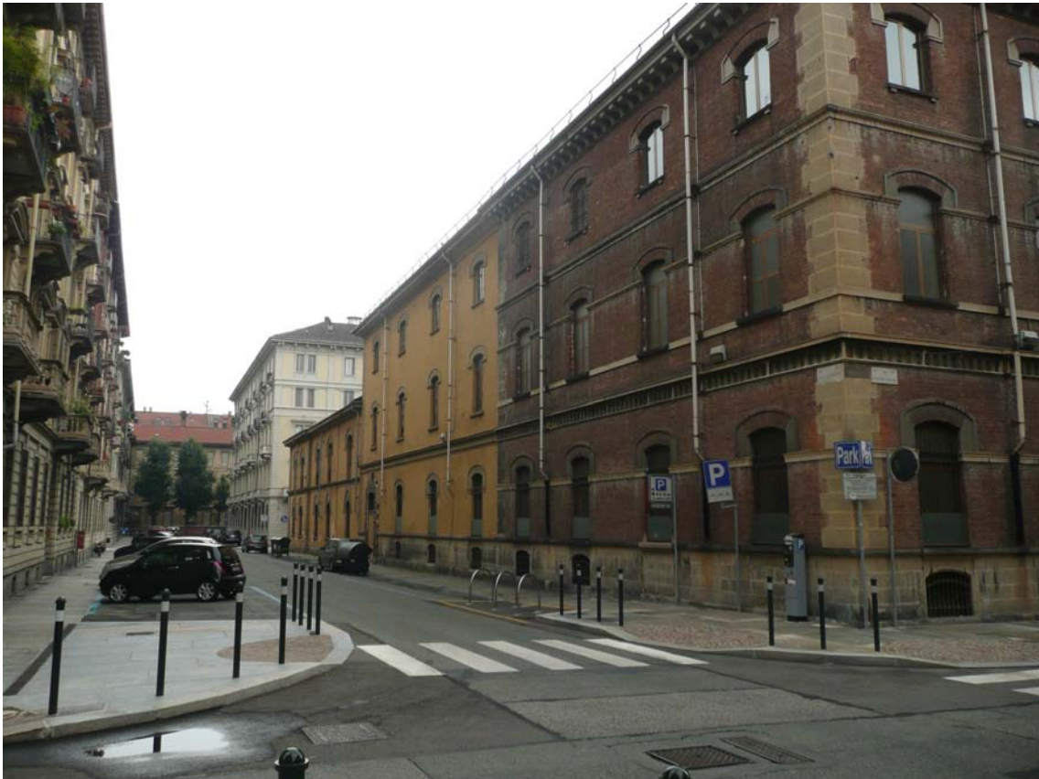
vista laterale via Donati angolo via Revel
