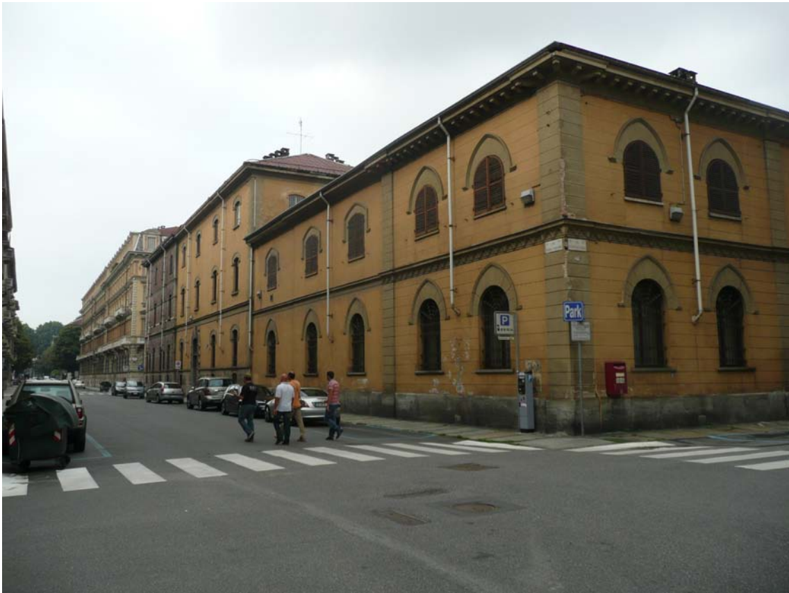
vista laterale via Avogadro angolo via De Sonnaz
