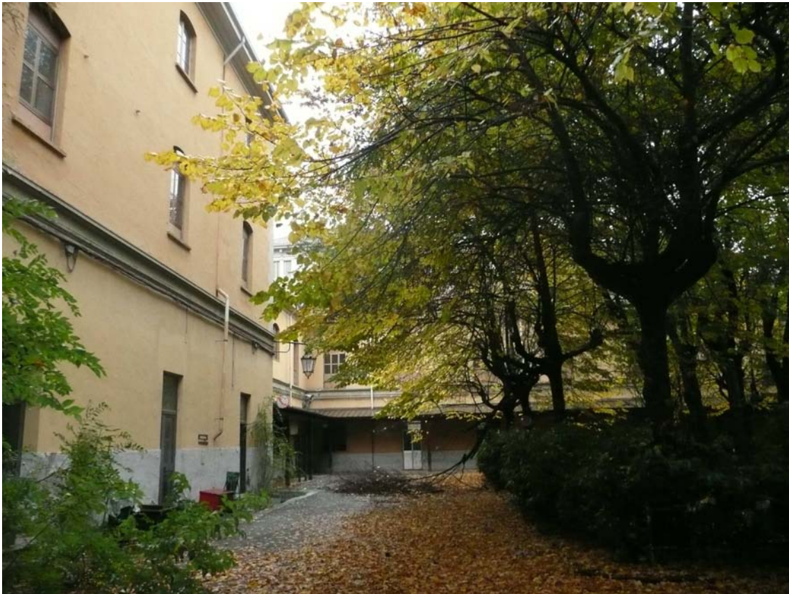
vista laterale via Donati angolo via De Sonnaz interno cortile
