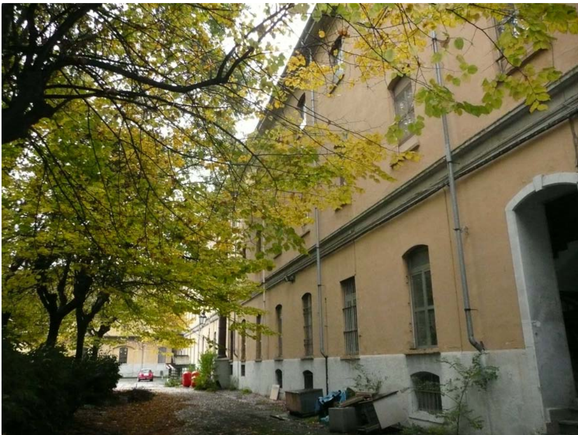
vista laterale via Revel angolo via Avogadro interno cortile
