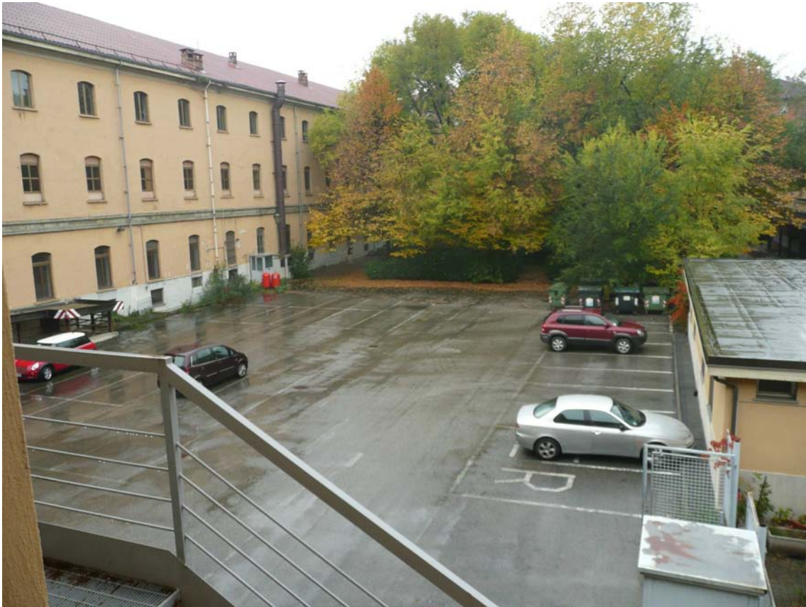
vista laterale via Revel interno cortile
