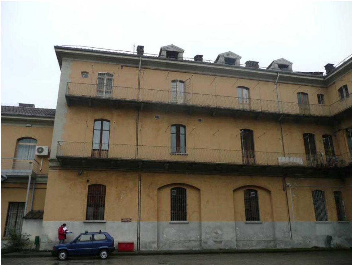
vista laterale via Avogadro interno cortile
