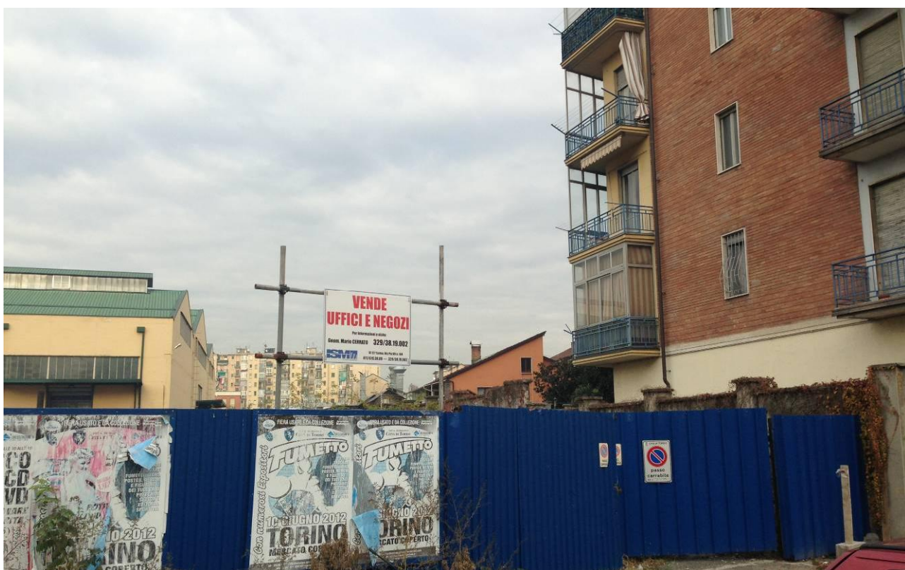
Accesso a area di intervento - Lato edificio residenziale esistente
