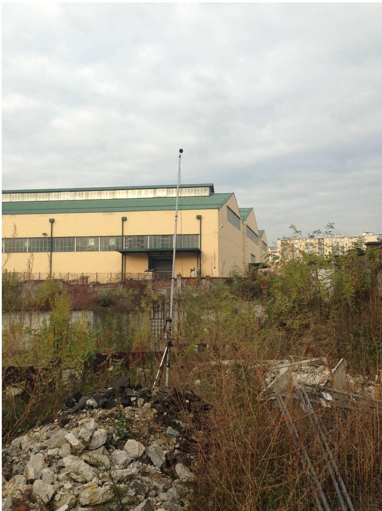
Punto 1, misura in continuo della durata di 48 ore, microfono posto ad h 4 mt
