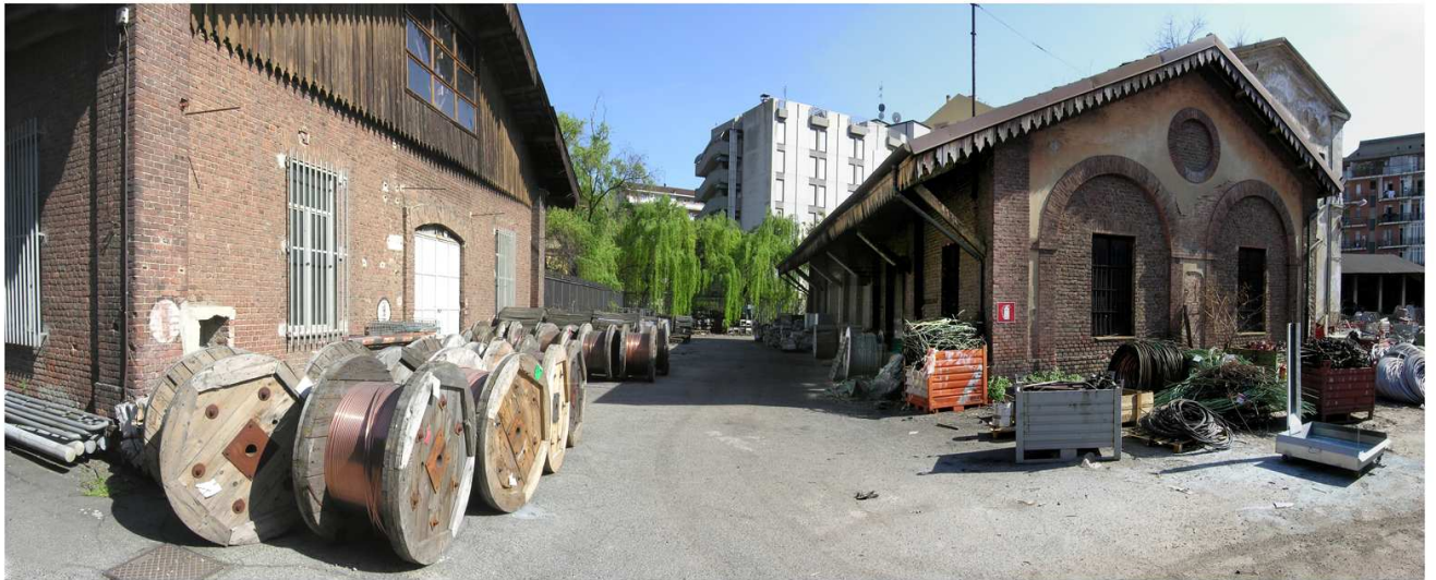
Vista degli edifici 11,12 e 13
