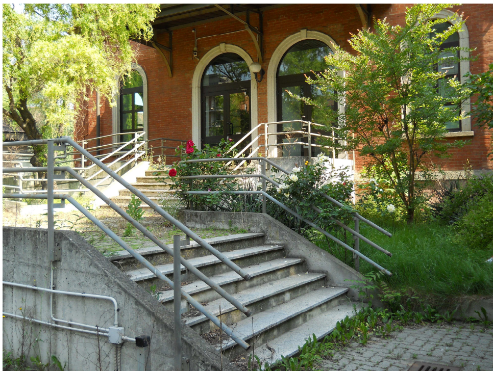
Edificio 8, particolare della scala di accesso lato sud
