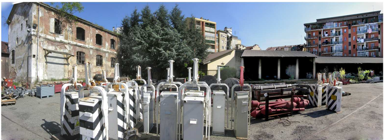
Vista degli edifici 12e 13
