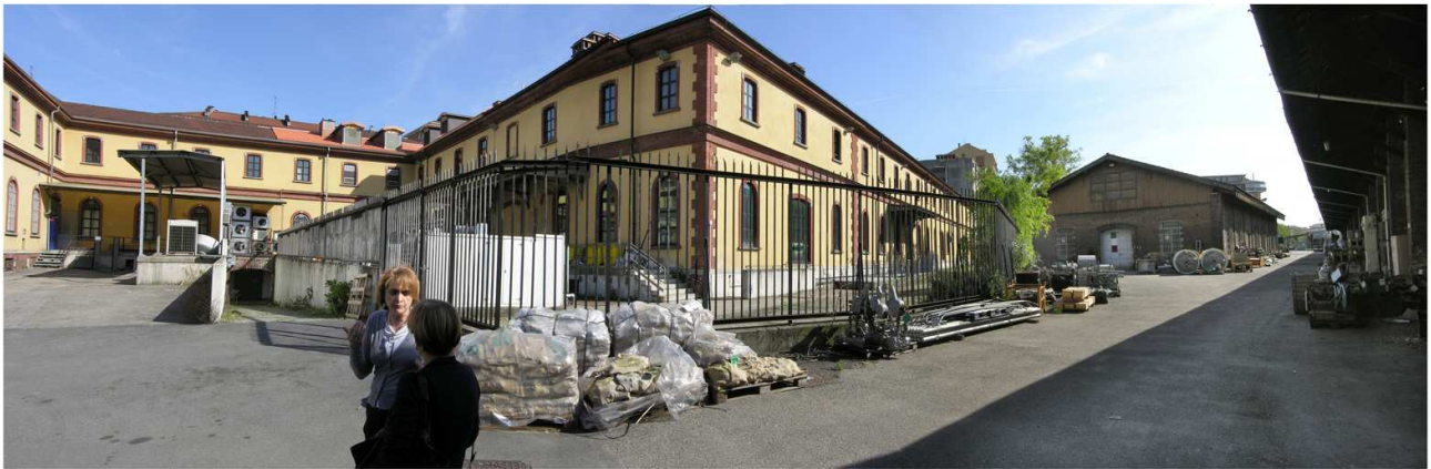
Vista dell'edificio 8, a destra fabbricati 9 e 10
