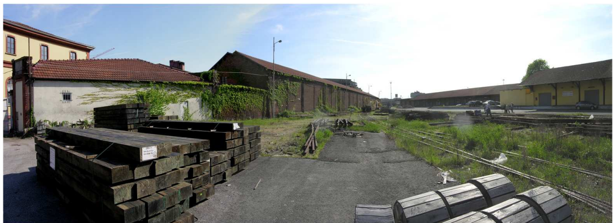
Vista dei fabbricati 10 e 16
