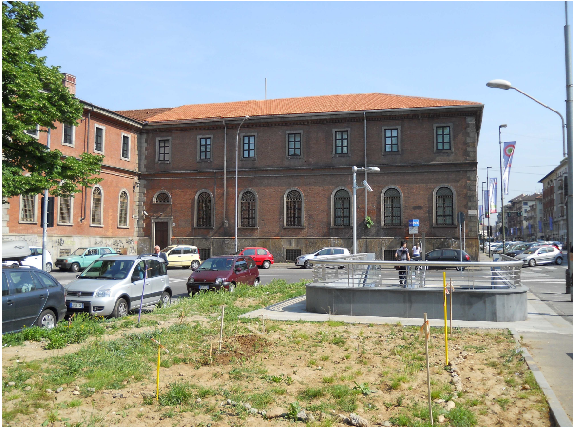
Vista dell' edificio 8, fronte su piazza Nizza
