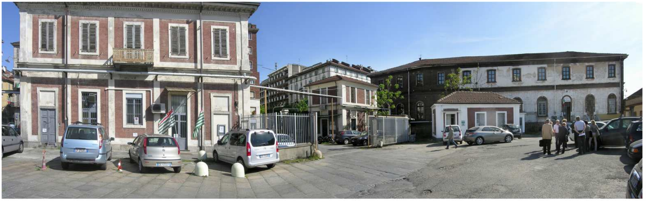
Vista degli edifici 2, 3,4,5,6e7
