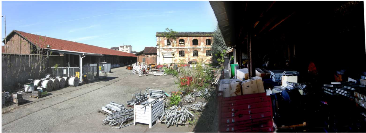
Vista degli edifici 10, 12 e 13
