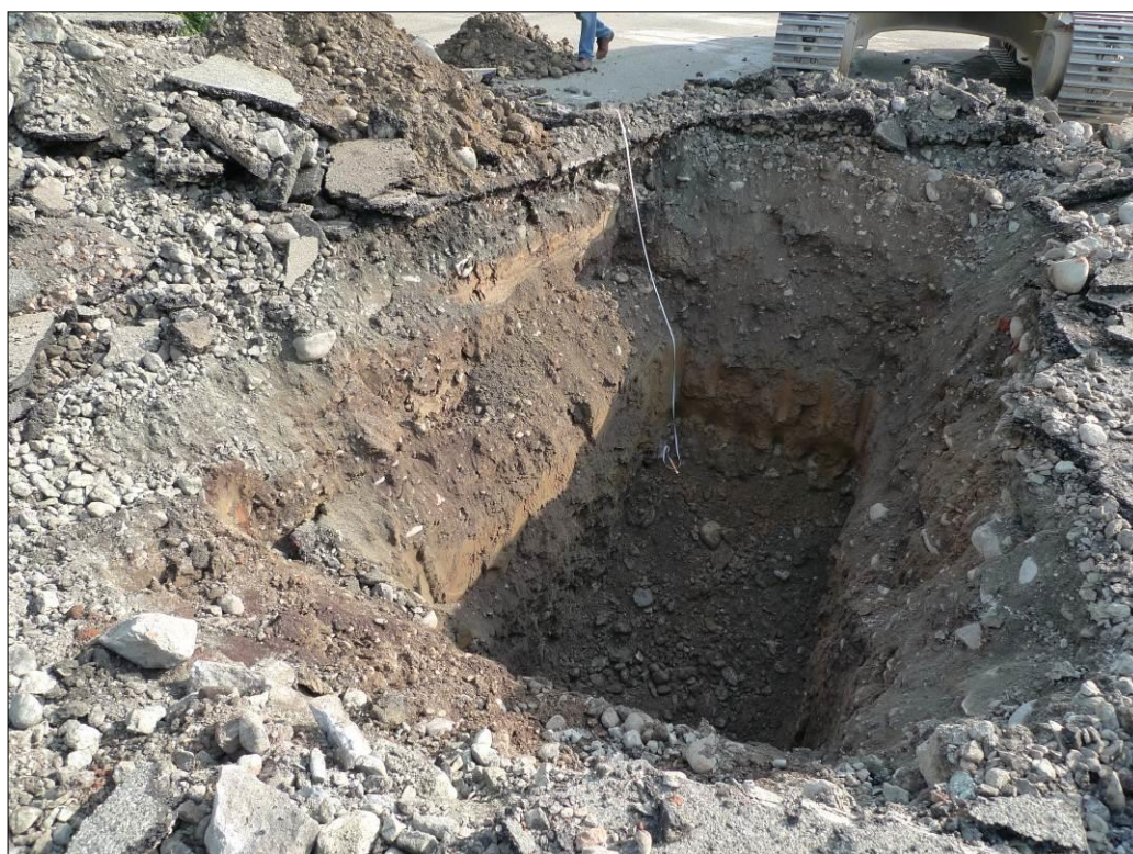
FOTO 14 - Pozzetto AG1 – in evidenza gli orizzonti analizzati
