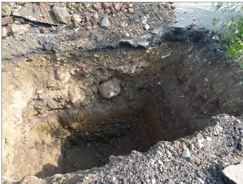
FOTO 16 - Pozzetto AG2 – in evidenza gli orizzonti analizzati
