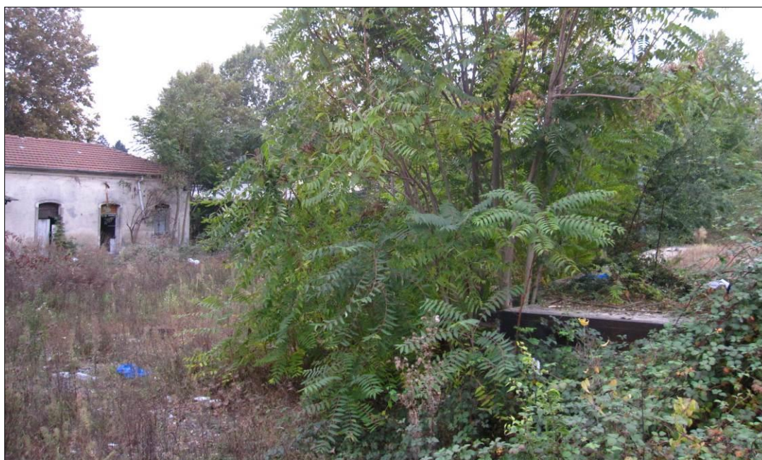
FOTO 4 – L'area caratterizzata dalla copertura diffusa con ballast ferroviario presenta un insediamento prevalentemente arboreo con novellame di ailanto, Prunus spp., pioppi, robinie e olmi.
