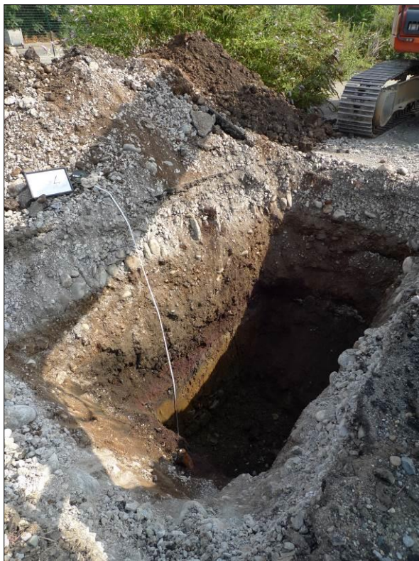
FOTO 20 - Pozzetto AG4 – in evidenza gli orizzonti analizzati
