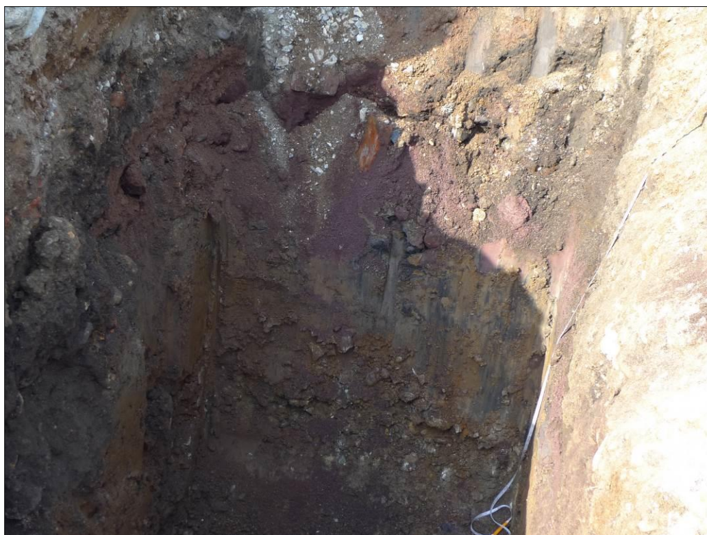
FOTO 21 - Pozzetto AG4 – particolari del 'Riporto con scorie' (colore violaceo)
