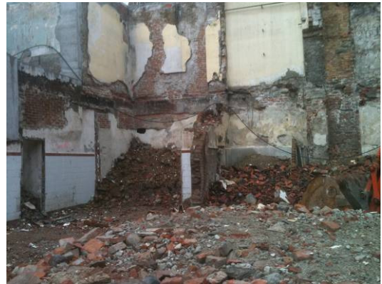
Strutture in corso di demolizione
