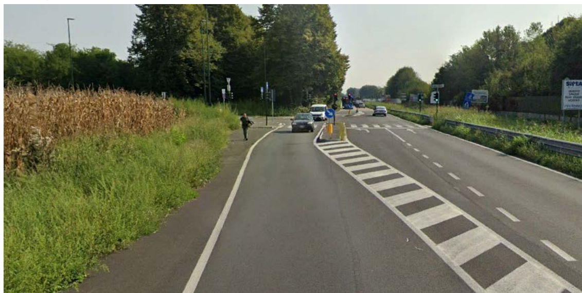
Figura 14 - Intersezione semaforizzata corso Romania e sovrappasso Falchera
