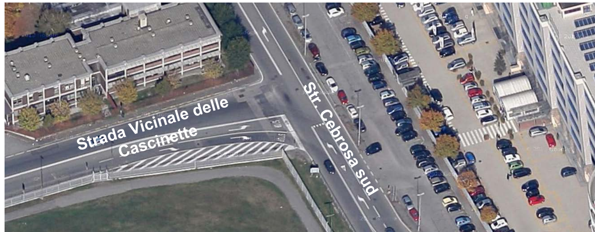
Figura 16 - Intersezione a raso tra strada Cebrosa sud e strada vicinale delle Cascinette
