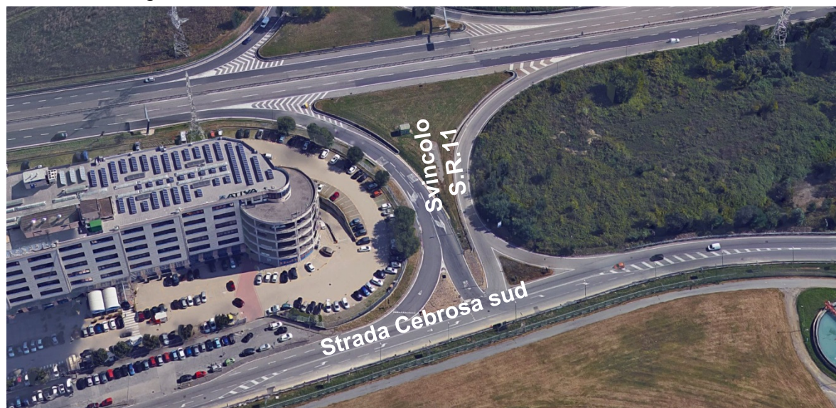
Figura 17 - Svincolo "Abbadia di Stura" - A55 raccordo Falchera
