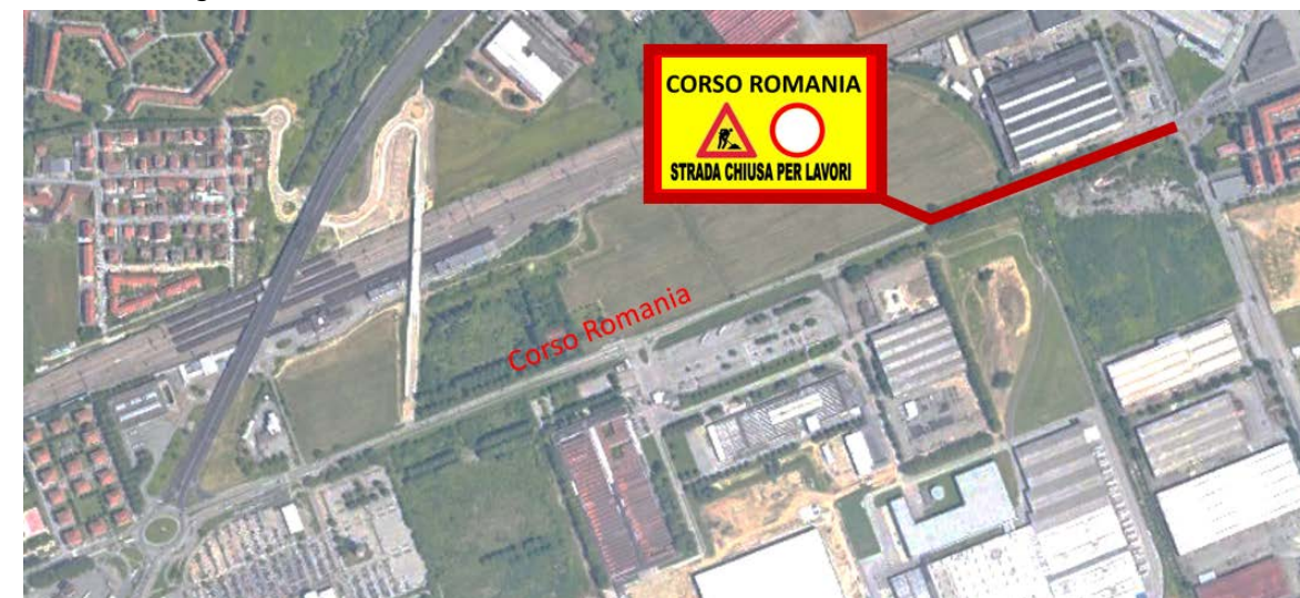
Figura 139 – Corso Romania – tratta chiusa in fase di cantierizzazione
