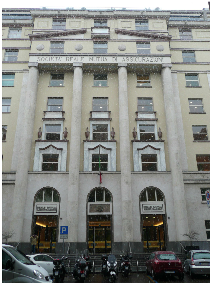
Vista imm.le lato via Corte d'Appello, 11
