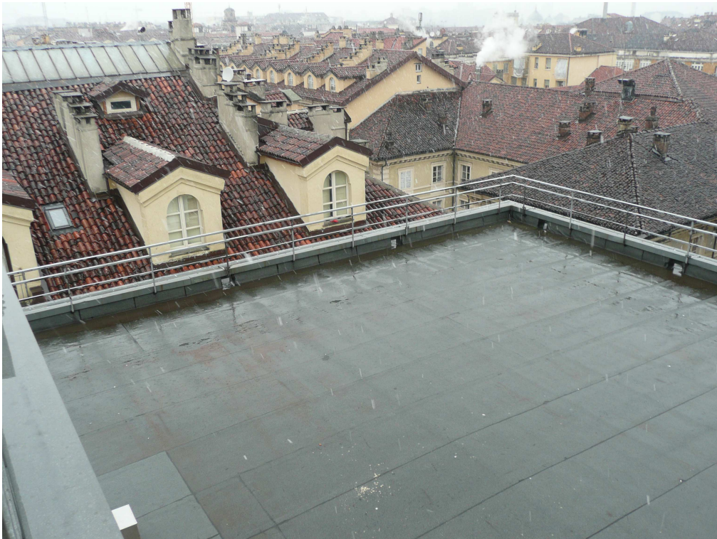
Vista esterna terrazzo al piano sesto lato via delle Orfane
