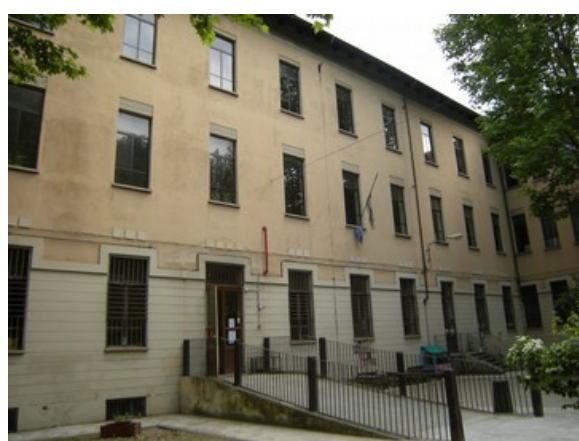
Prospetto cortile interno
