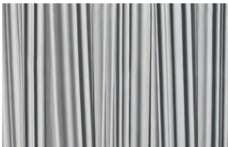
Figura 7 Esempi di pareti di tamponamento in c.a. realizzate con matrici da stampo.
