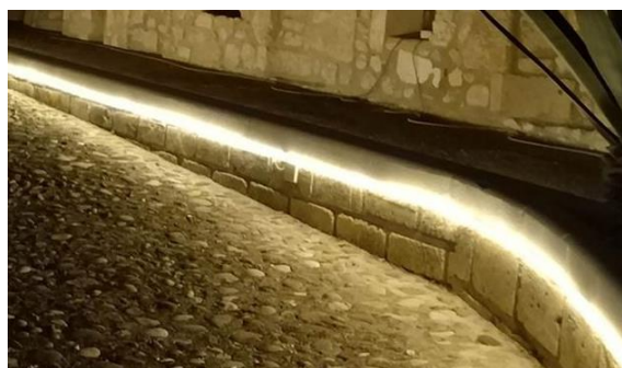
Figura 12 – Esempi copertina in mattoni di coltello (alto sx) e muretti faccia a vista (alto dx) e illuminazioni radenti con led sotto copertina (in basso).
