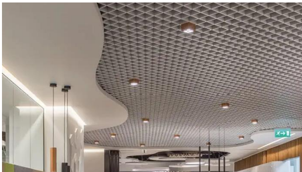
Figura 8 – Esempi controsoffitti grigliati (sx) e a doghe (dx).
