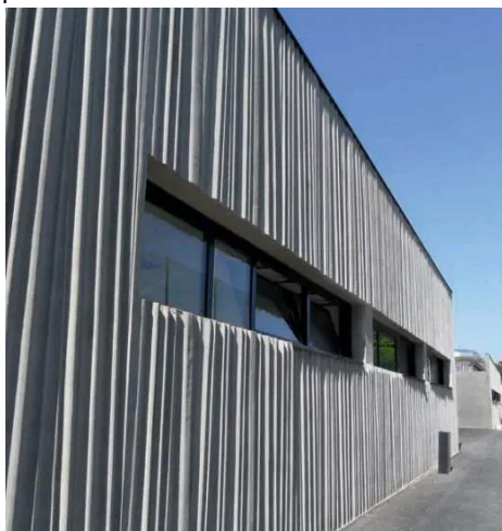
Figura 7 Esempi di pareti di tamponamento in c.a. realizzate con matrici da stampo.
