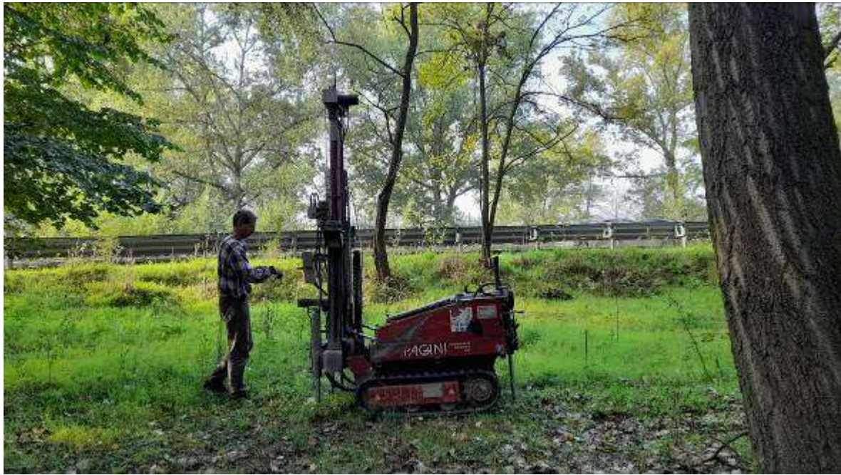
Figura 15 - Esecuzione della prova penetrometrica DIN2
