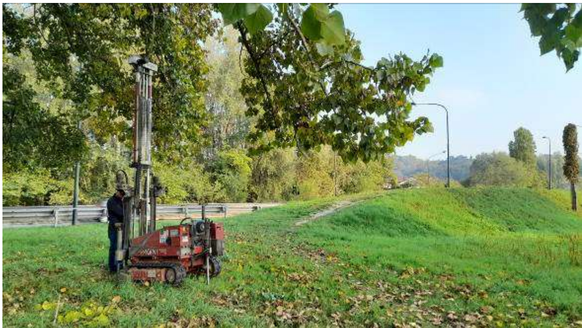
Figura 16 - Esecuzione della prova penetrometrica DIN3
