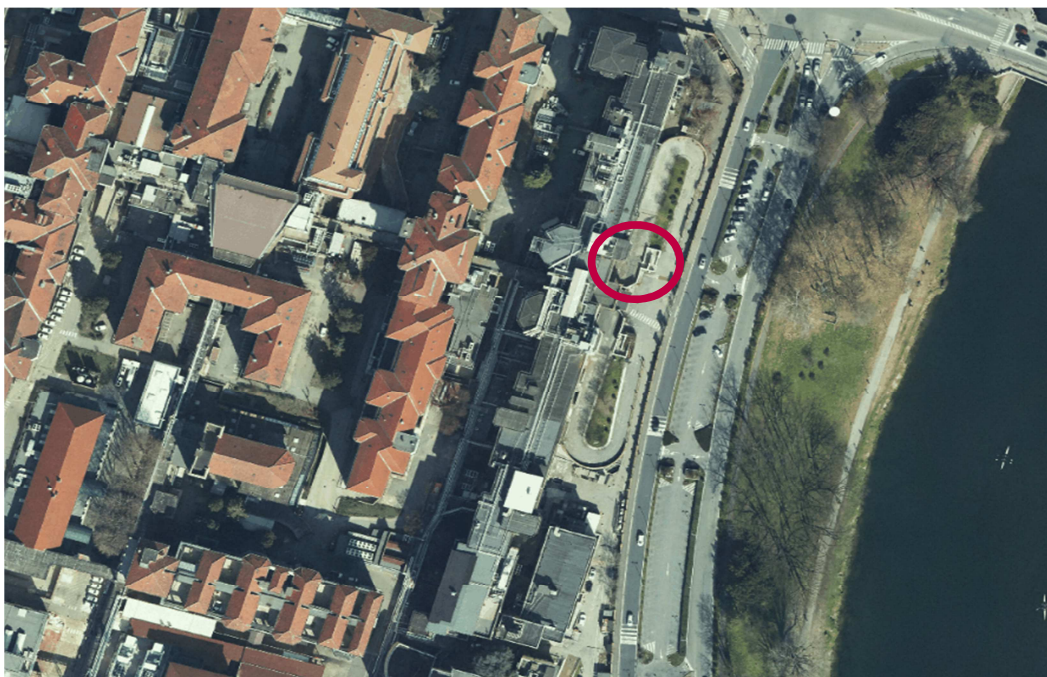
Vista aerea - Presidio Ospedaliero Molinette - Area d'intervento
