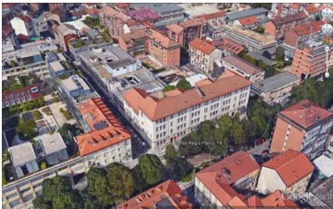
Inquadramento aerofotogrammetrico dell'edificio oggetto di analisi [fonte Google Earth]
