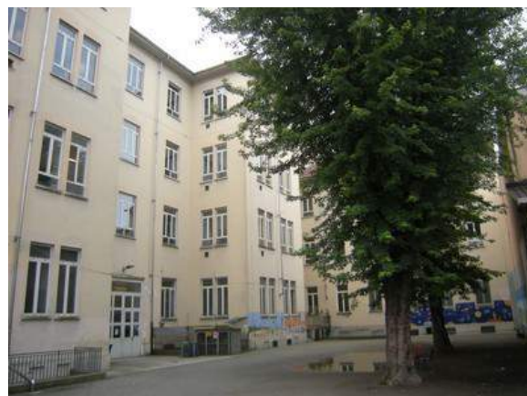
Prospetto cortile interno lato aule
