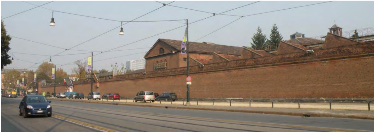
Figura 26. Ex Carcere Le Nuove, vista da via Nino Bixio
