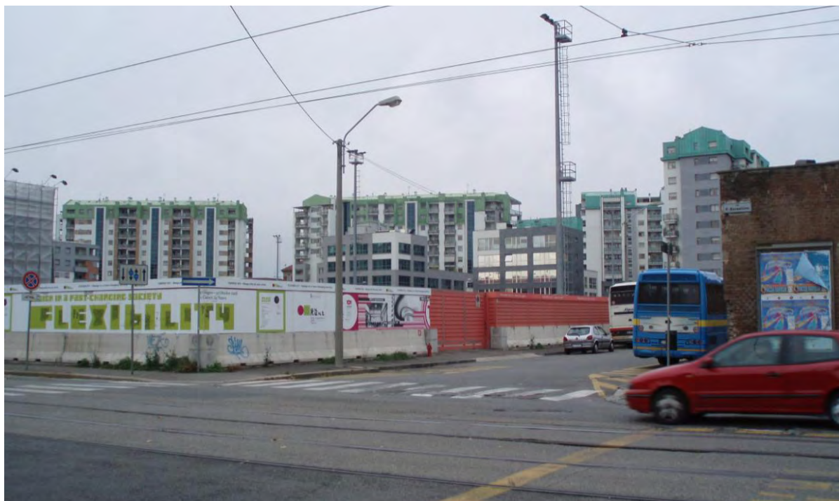
Figura 51. Visuale dell'ambito da via Borsellino angolo via Bixio
