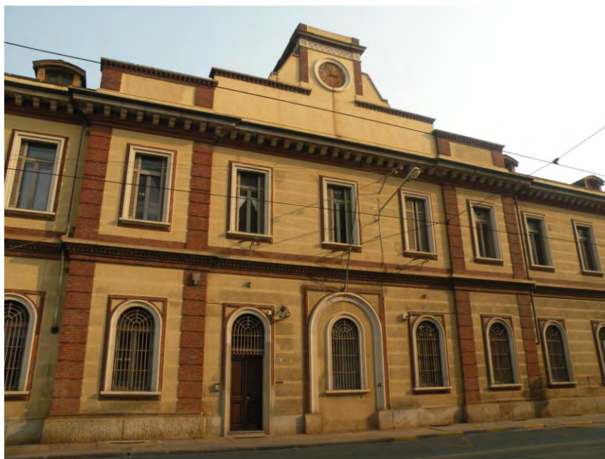
Figura 32. Officine ferroviarie Via Boggio.
