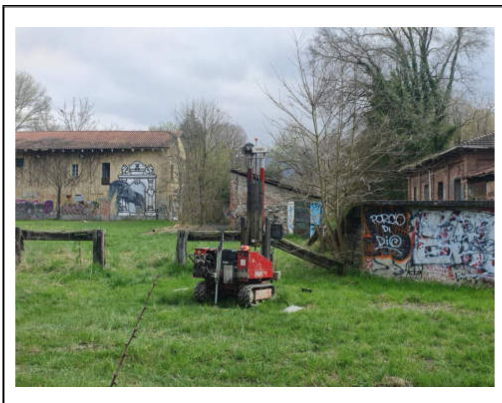
Foto 3: Posizionamento prova penetrometrica dinamica DPSH 3.
