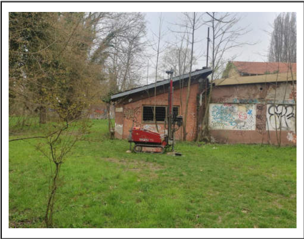
Foto 1: Posizionamento prova penetrometrica dinamica DPSH 1.
