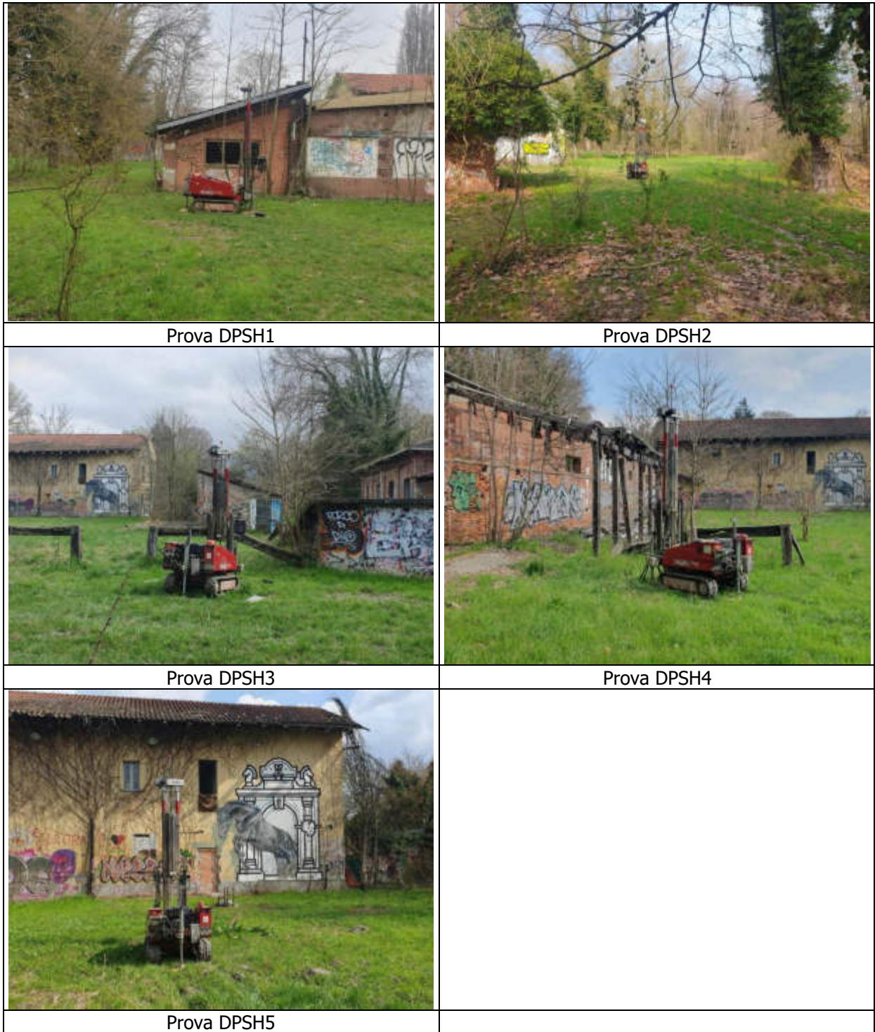
Figura 4.1-2: Documentazione fotografica delle prove penetrometriche eseguite.
