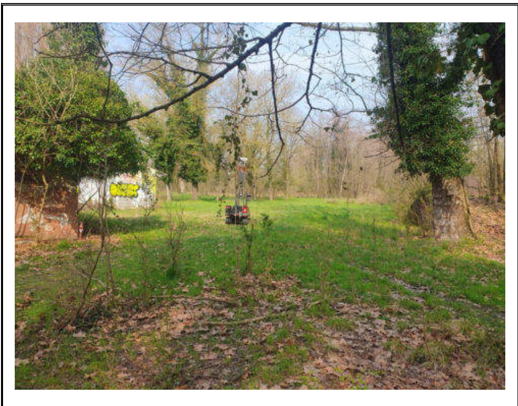
Foto 2: Posizionamento prova penetrometrica dinamica DPSH 2.
