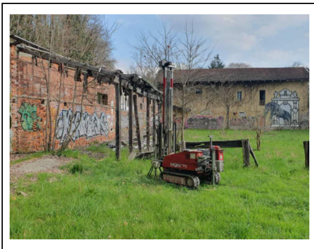
Foto 4: Posizionamento prova penetrometrica dinamica DPSH 4.
