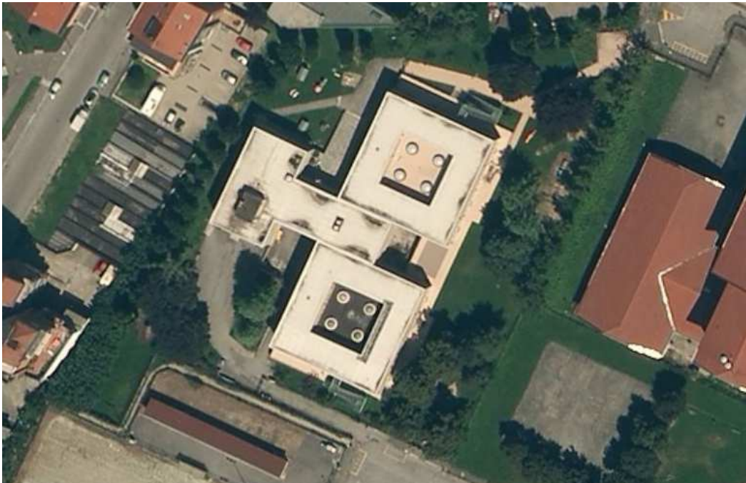
Figura 14 – inquadramento aerofotogrammetrico dell’edificio
