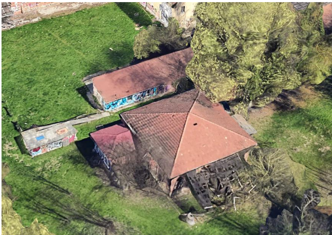
Figura 2 Stato di fatto – copertura edificio F
