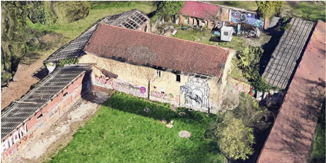
Figura 1 Stato di fatto – copertura edificio G
