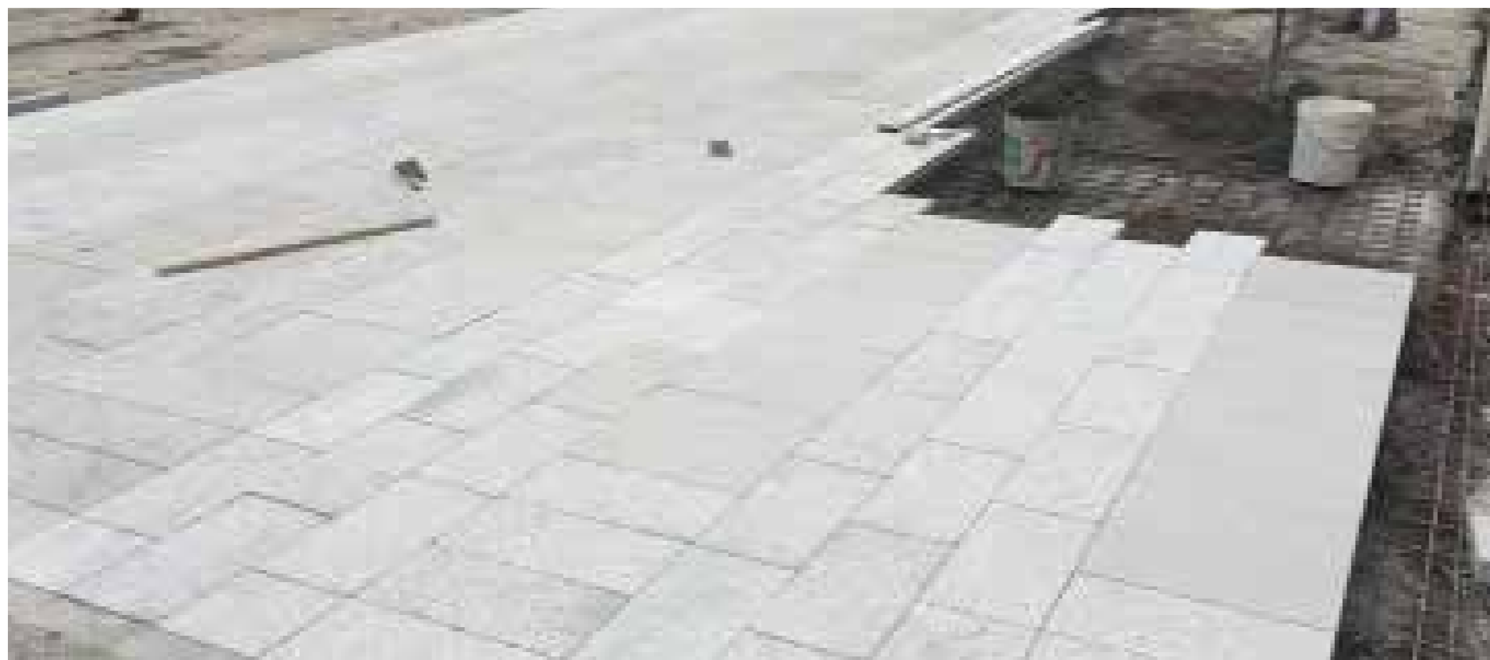
esempio di applicazione e di posa di una pavimentazione in granito
