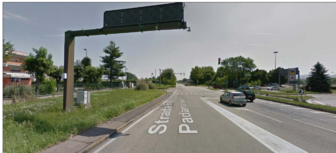
Figura 60 – Corso Romania, direzione Settimo Torinese, nei pressi dell'intersezione semaforizzata con strada Vicinale dell'Abbadia di Stura
