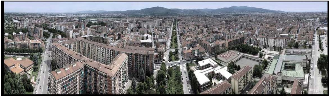
Figura 19 – Il trincerone Sempione-Gottardo, vista verso ovest, in primo piano a destra l’Ospedale Giovanni Bosco
