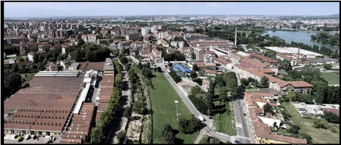
Figura 17 - Area di Scalo Vanchiglia, inizio del Trincerone, vista verso nord; a destra si intravede la Manifattura Tabacchi e il Po
