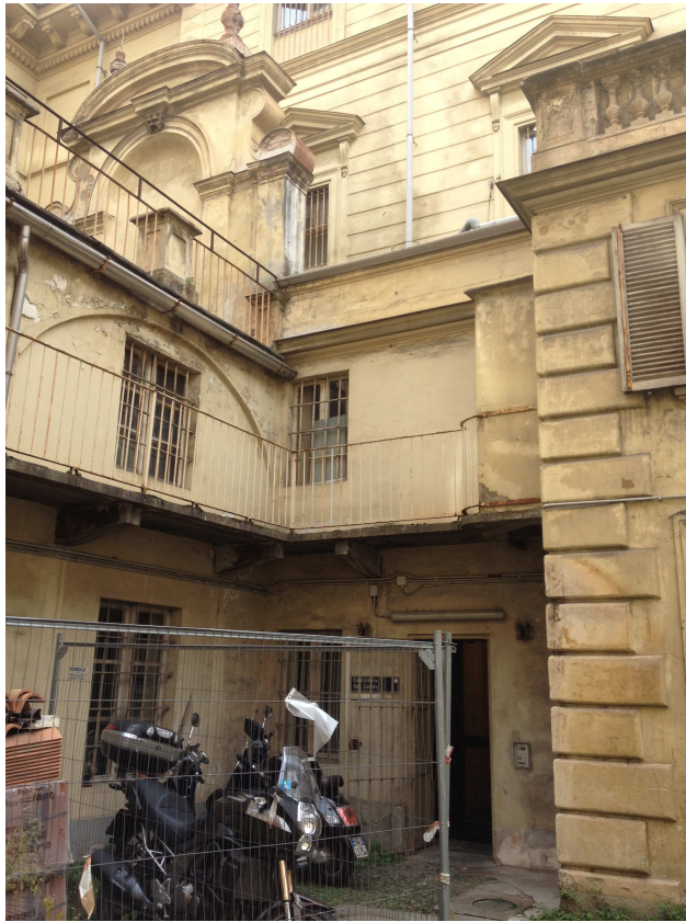
Vista interno cortile lato via Corte d'Appello 14
