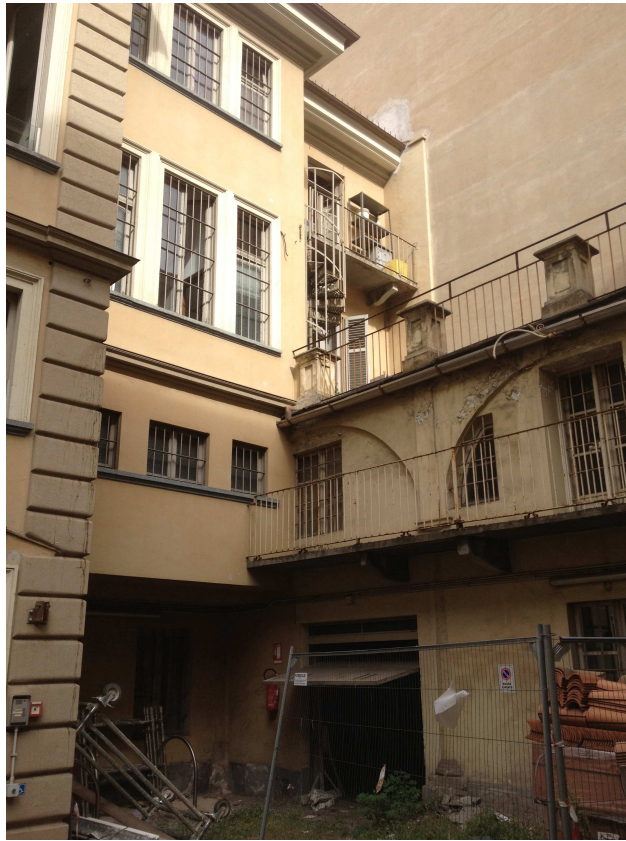
Vista interno cortile lato via Corte d'Appello 14
