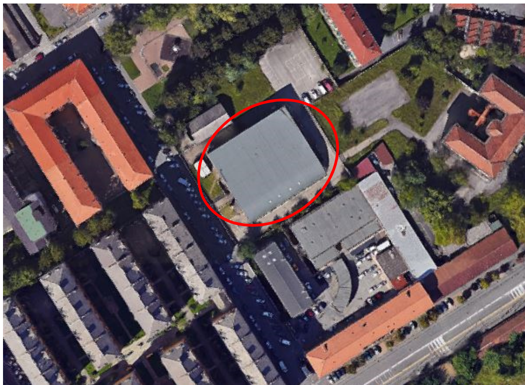
Inquadramento aerofotogrammetrico dell'edificio oggetto di analisi
