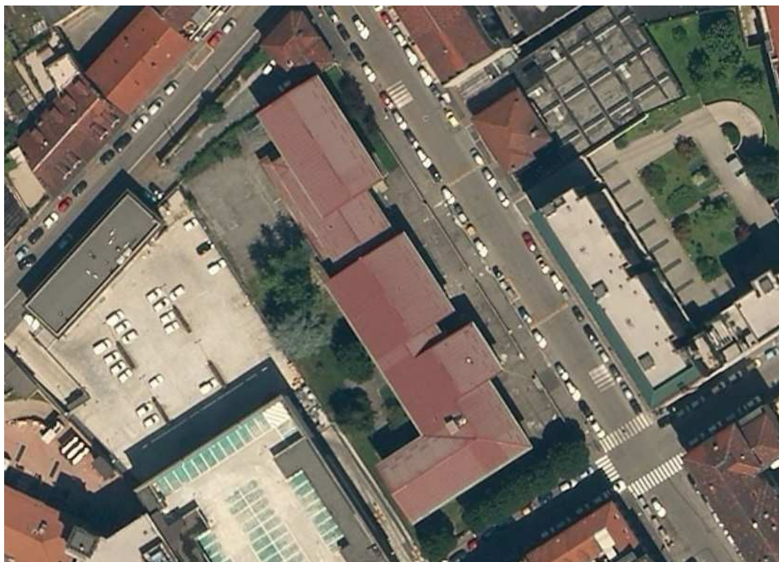
Figura 14 – inquadramento aerofotogrammetrico dell'edificio
