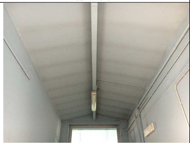
Corridoio ingresso palestra
