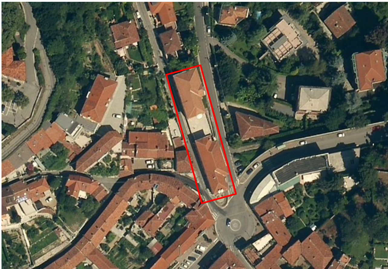
Figura 2 - Vista aerea dell'edificio oggetto di analisi
