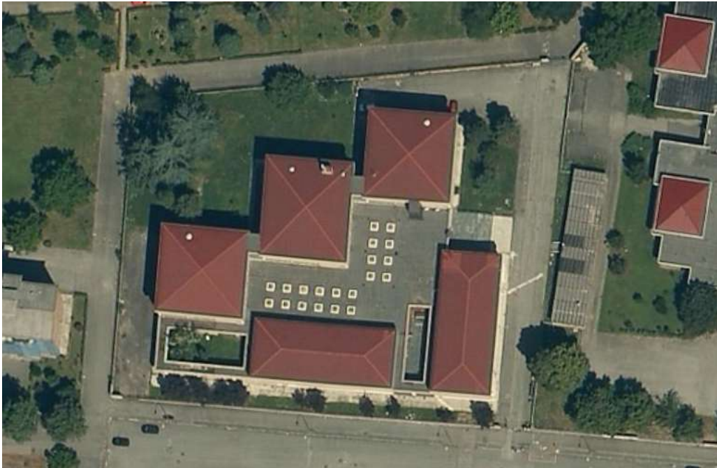
Figura 14 – inquadramento aerofotogrammetrico dell'edificio
