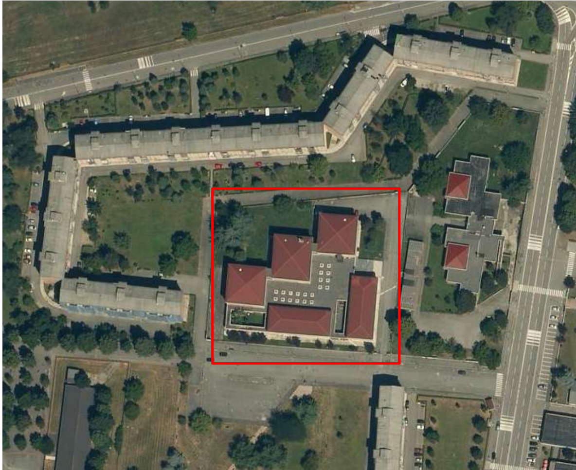
Figura 2 - Vista aerea dell'edificio oggetto di analisi
