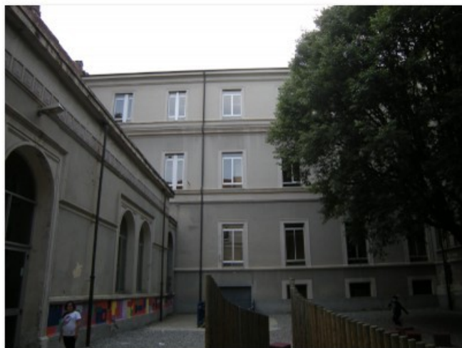
Particolare cortile interno
