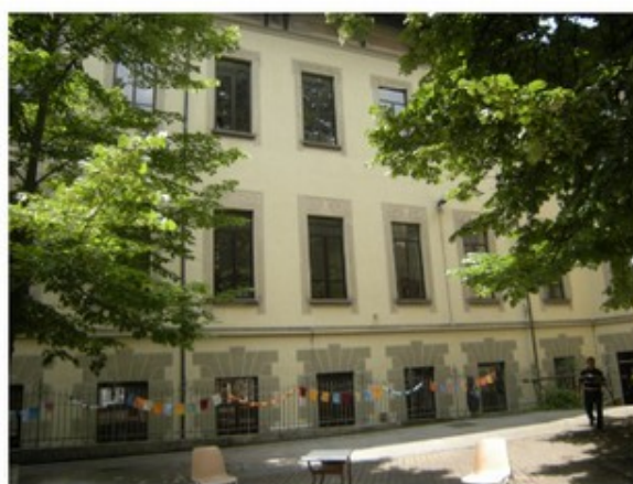
Prospetto cortile interno
