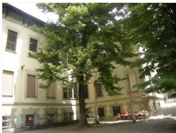
Prospetto cortile interno
