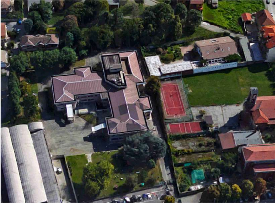
Figura 2 - Vista aerea dell'edificio oggetto di analisi
