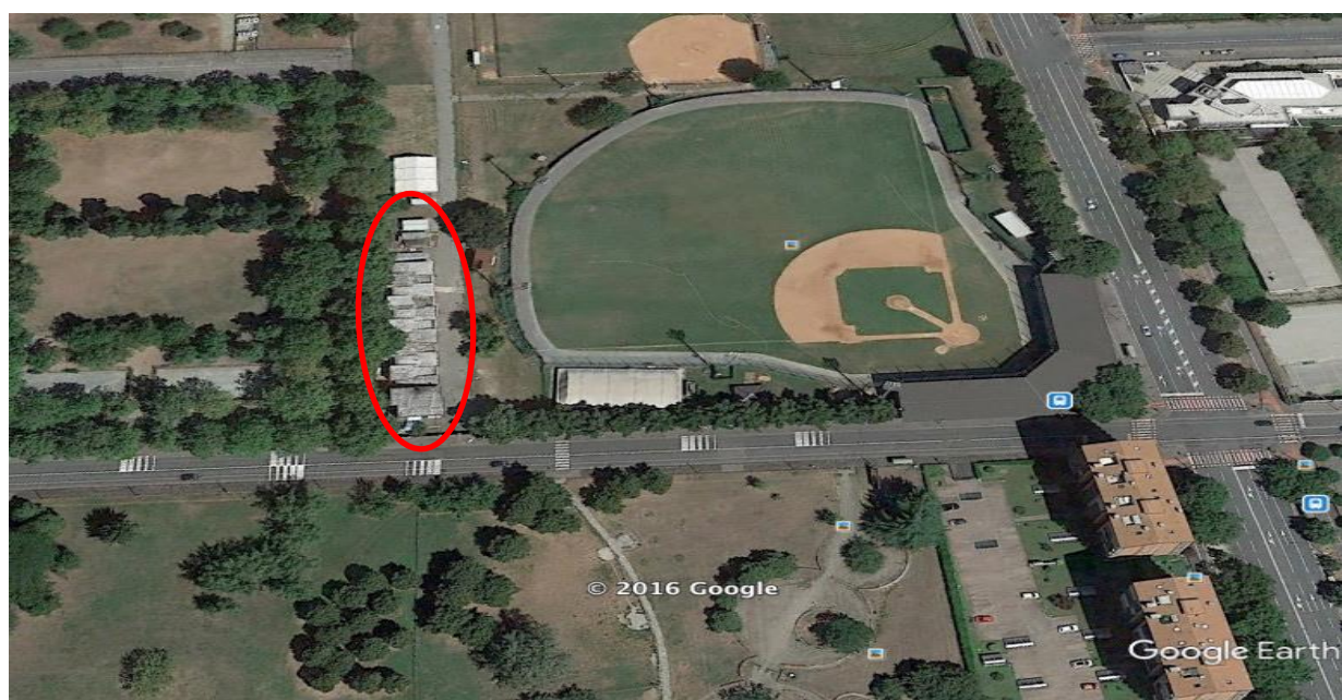
Inquadramento aerofotogrammetrico dell'edificio oggetto di analisi
