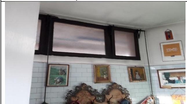
Immagine interna delle finestre alte
