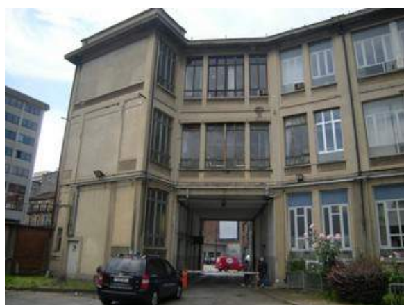
Prospetto cortile interno
