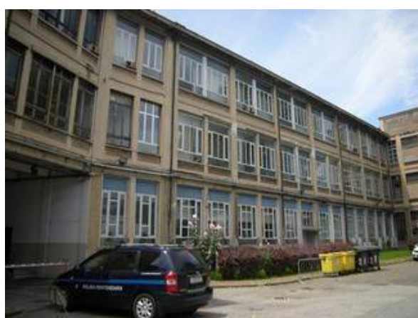
Prospetto cortile interno
