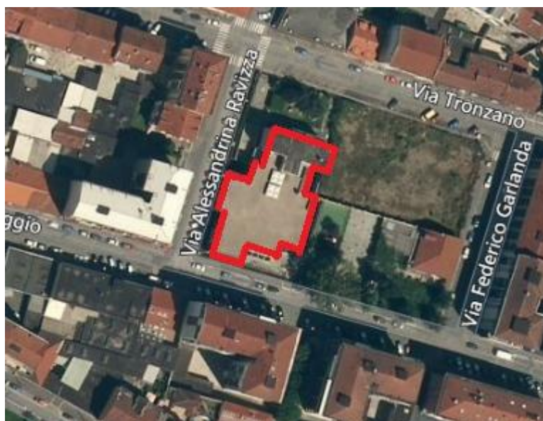
Figura 2 - Vista aerea dell'edificio oggetto di analisi
